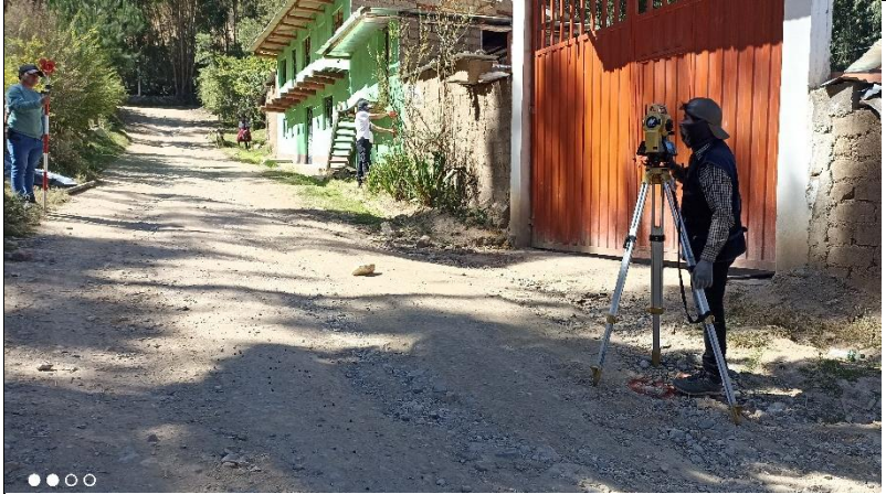
Fotografía N° 08: Colocación de BM
