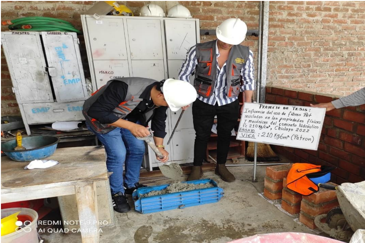
NOTA: Moldeo de la Viga de concreto (patrón).
