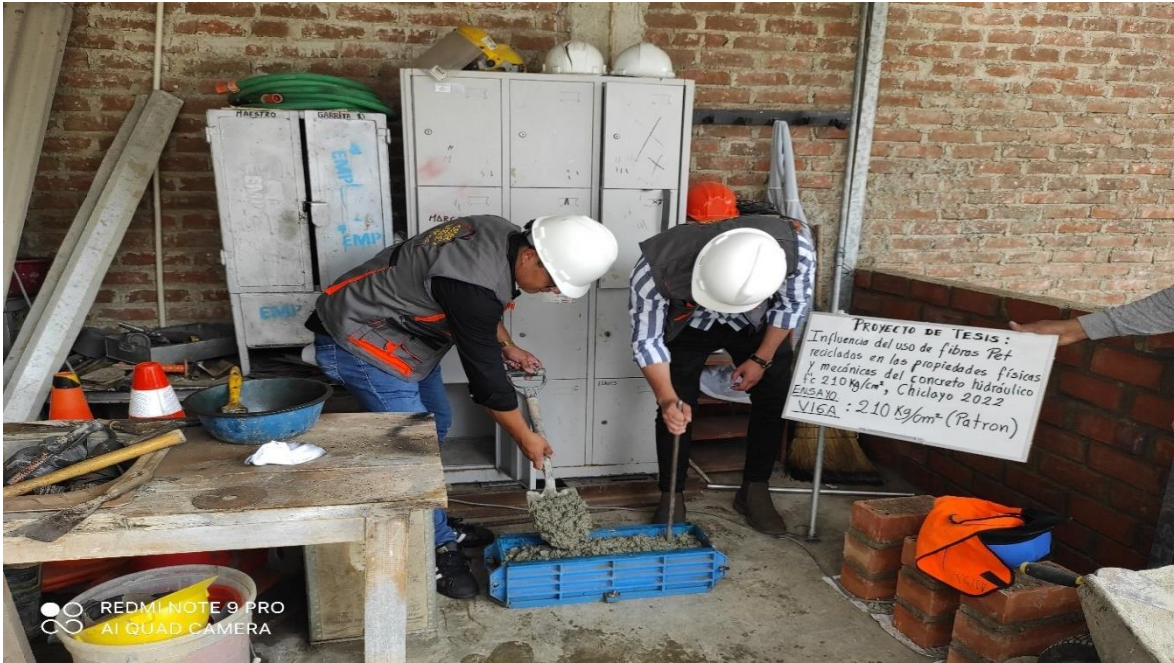
NOTA: Moldeo de la Viga de concreto (patrón).
