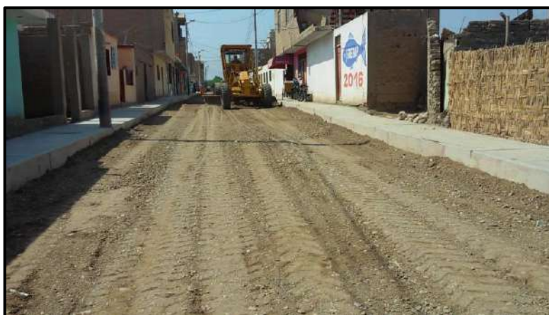
Figura 5. Nivelado de una subbase
