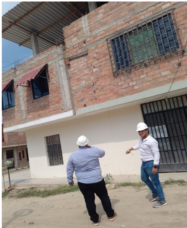
Figura 22: Los autores observando la construcción en volado en E - 6
