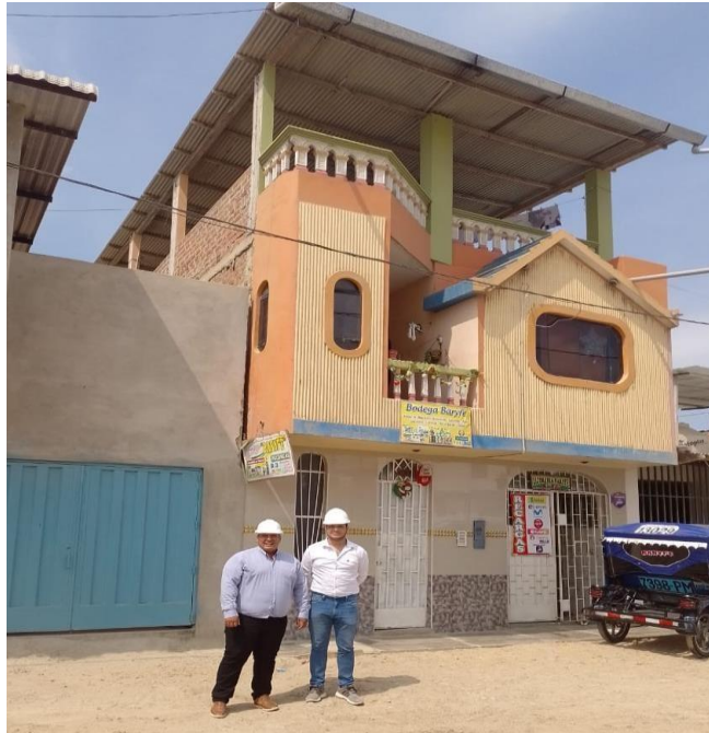
Figura 19: Los tesisistas frente a la edificación E-18
