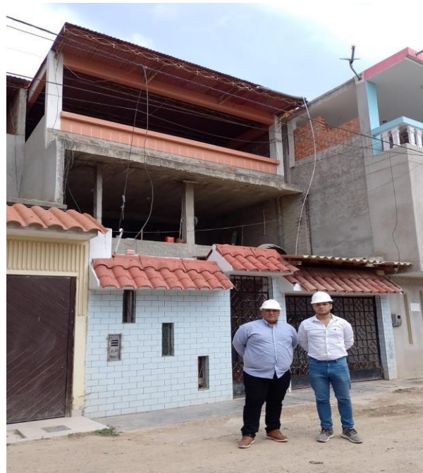
Figura 20: Durante un descanso del trabajo de campo en la edificación E-9
