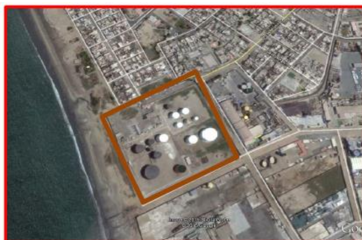
Figura 7 Vista Satelital del Terminal de Abastecimiento Chimbote
