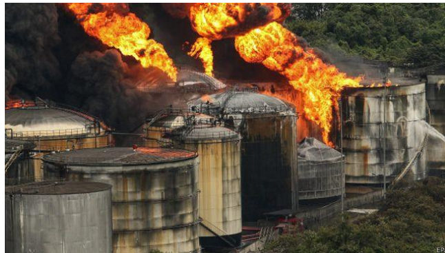
Figura 1 Incendio en tanques de hidrocarburos
