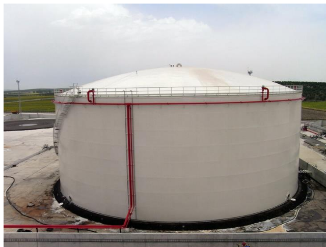
Figura 3 Tanque de techo flotante
