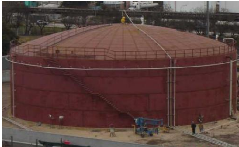
Figura 2 Tanque de techo fijo
