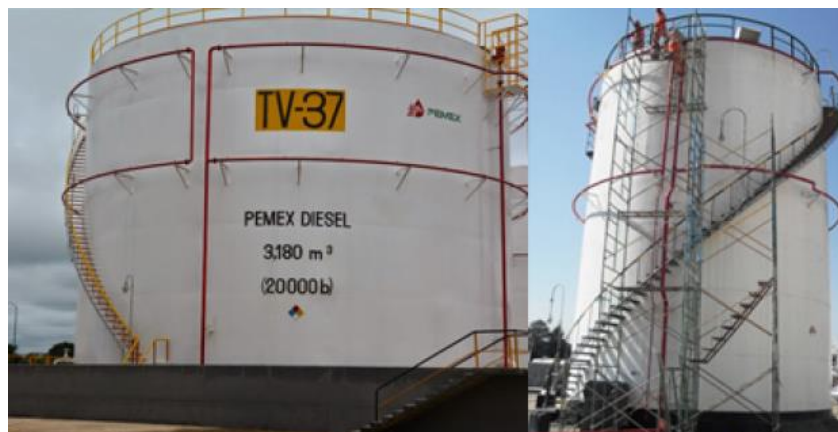
Figura 4 Tanque con anillos de enfriamientos
