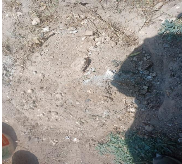
Figura 6. Preparación del terreno
