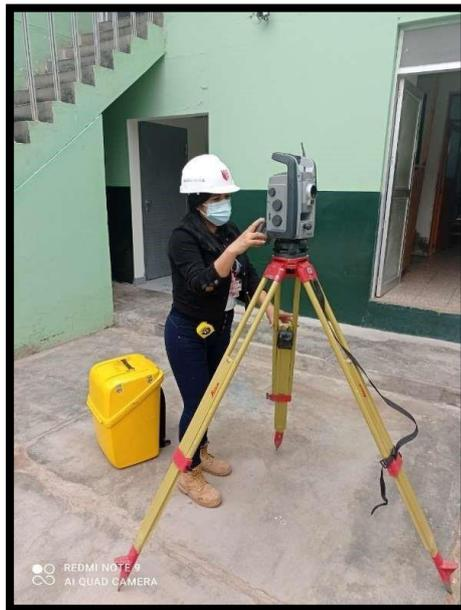
Fig. 5: Nivelación con el equipo topográfico para el levantamiento interno del complejo policial “Félix Tello Rojas” avenida Salaverry N° 929 - Chiclayo.
