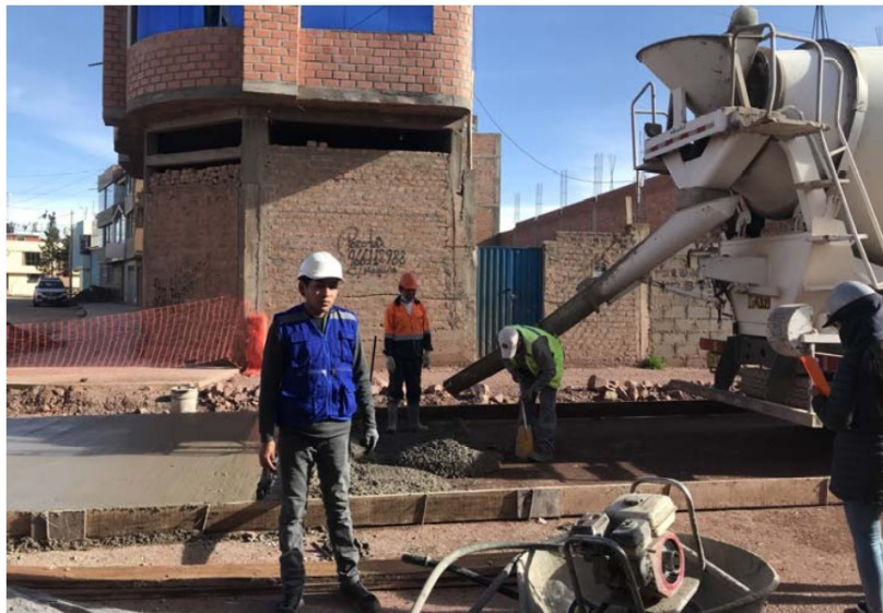
Fotografía 12. Ensayo de asentamiento en campo - Muestra in situ (A)
