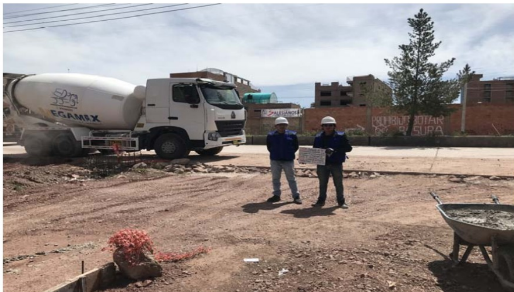
Fotografía 2. Recepción de Mezcla de concreto premezclado f'c=210\text{kg/cm}^2 en campo - MEGAMIX
