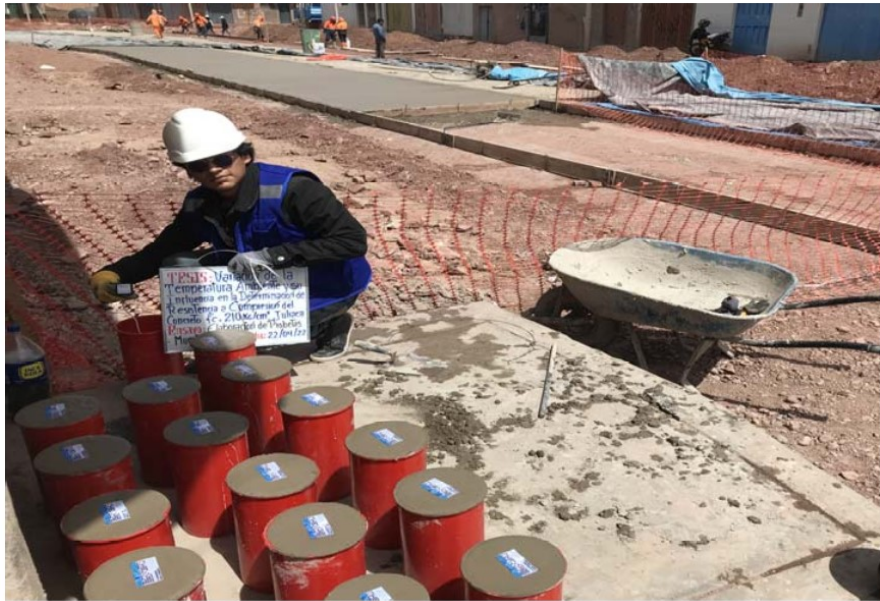
Fotografía 5. Instalación de sensores SmartRock2 - Muestra Patrón (P)
