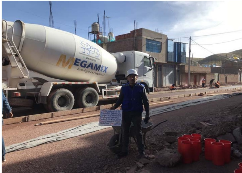
Fotografía 11. Elaboración de probetas - Muestra no sumergida in situ (A)
