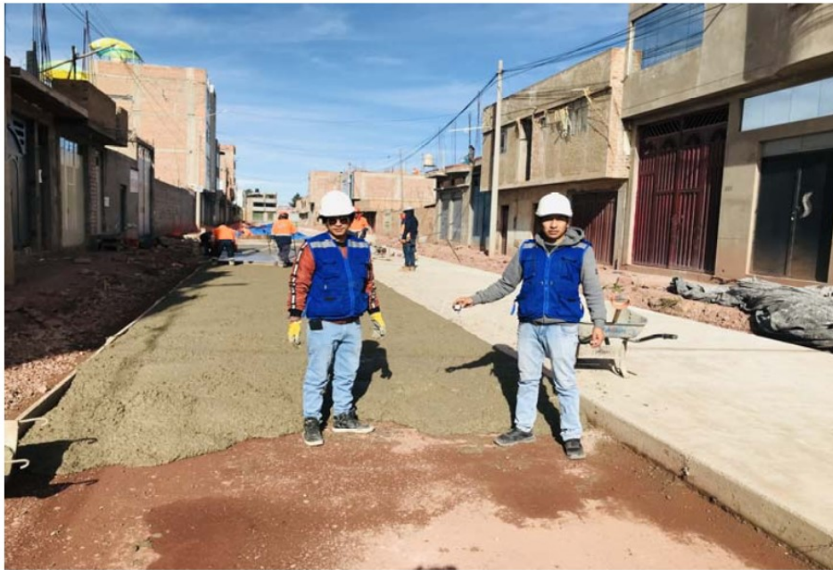
Fotografía 21. Instalación del sensor SmartRock2 en el pavimento rígido in situ (PV) - Jr. Guatemala Juliaca.
