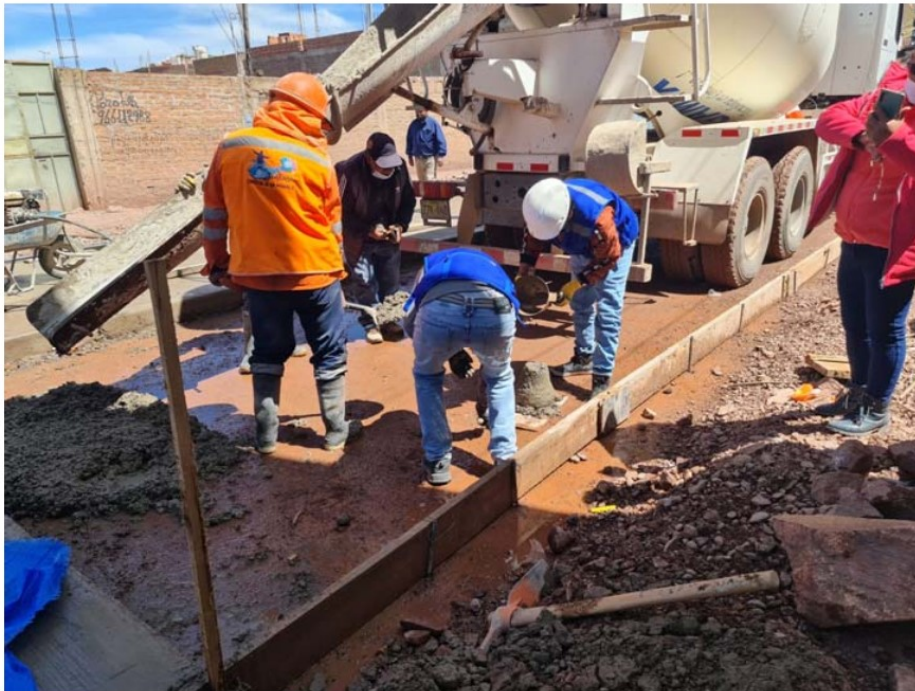
Fotografía 17. Ensayo de asentamiento en campo - Muestra sumergida in situ (B)
