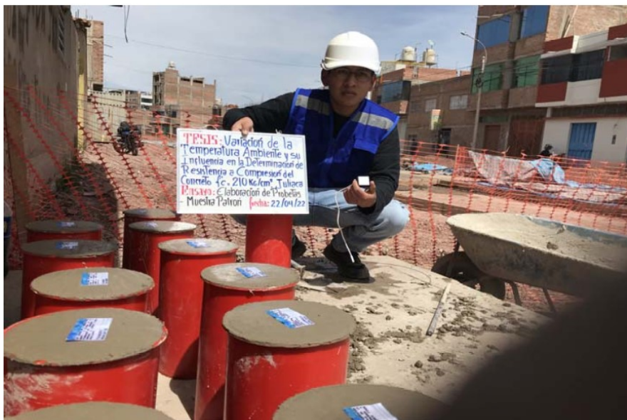
Fotografía 6. Instalación de sensores SmartRock2 - Muestra Patrón (P)
