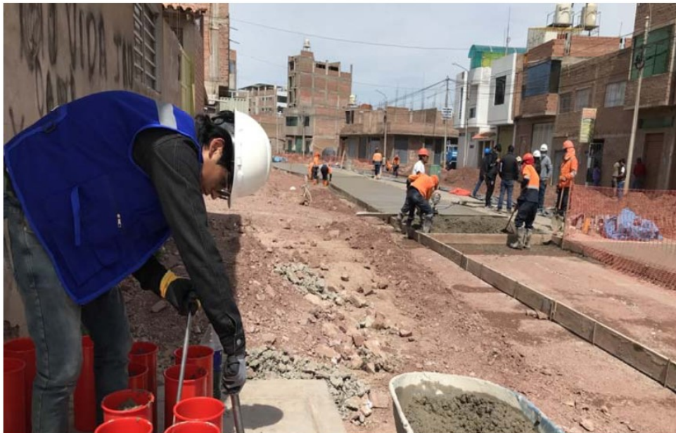
Fotografía 4. Elaboración de probetas - Muestra Patrón (P)
