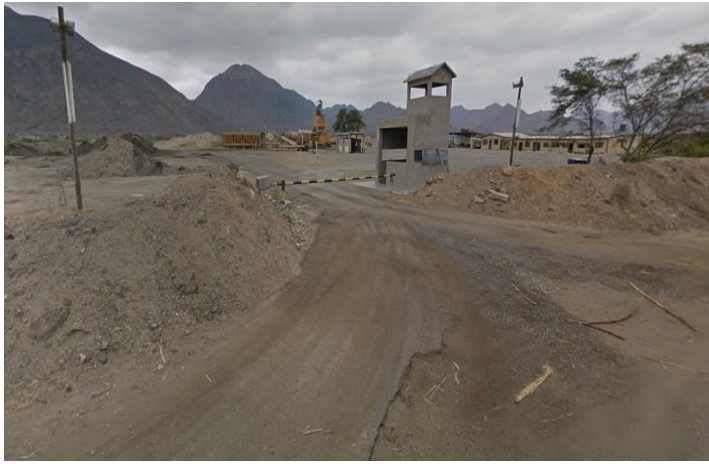
Figura 5.Planta asfáltica- Gobierno Regional Lambayeque
