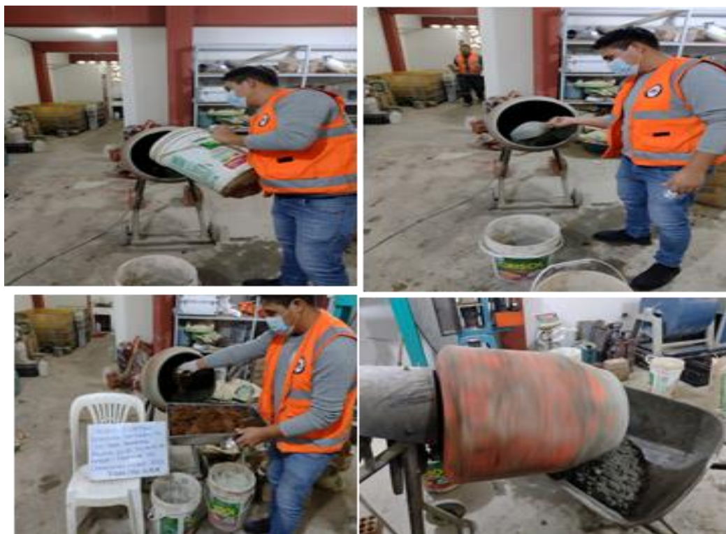
Figura 64. Preparación del concreto para muestreos
