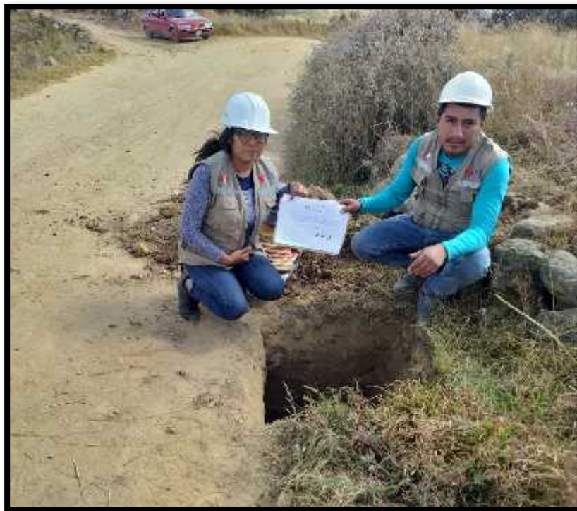
Calicata N.º 2 Estudio de Mecánica de Suelos
