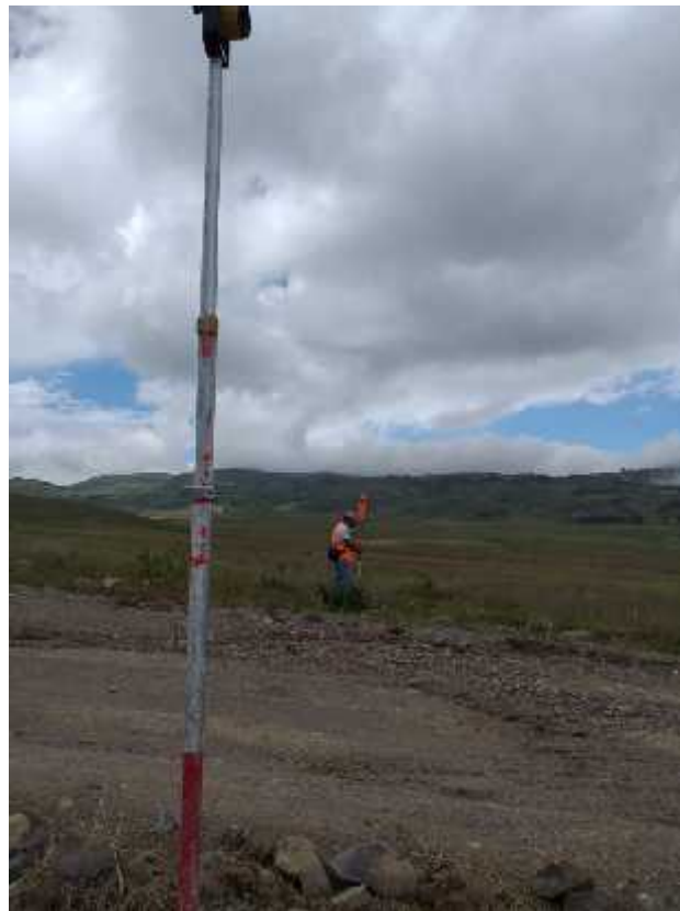
Levantamiento Topográfico, prismas en relleno de carretera
