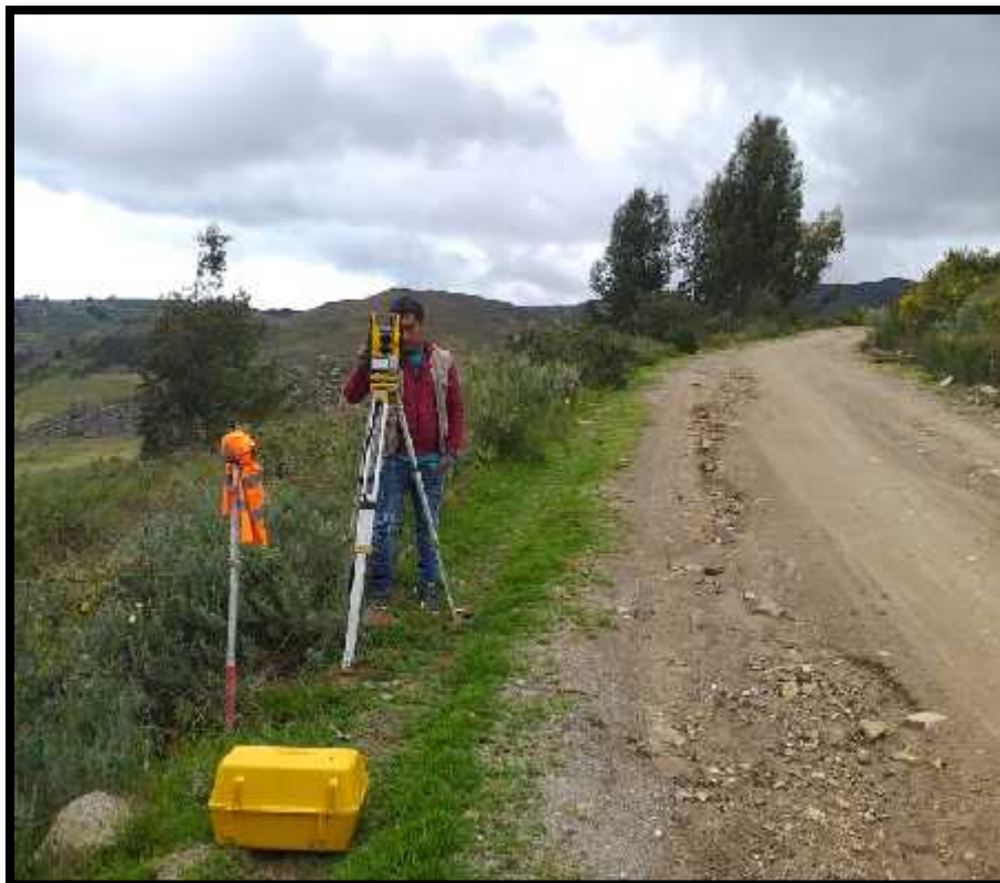
Levantamiento Topográfico, insertando coordenadas BM atrás
