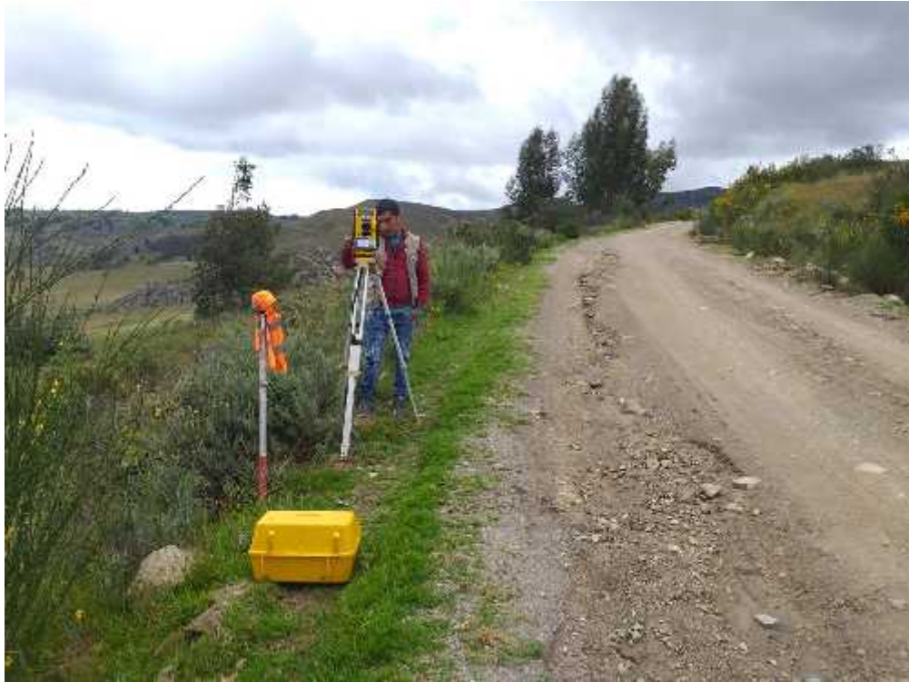
Levantamiento topográfico, nivelando la estación total.
