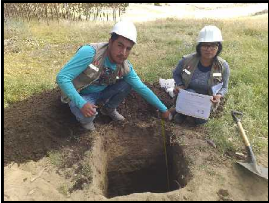
Calicata N.º 3 Estudio de Mecánica de Suelos
