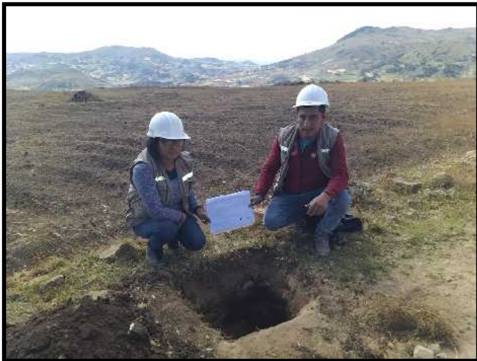
Calicata N.º 6 Estudio de Mecánica de Suelos
