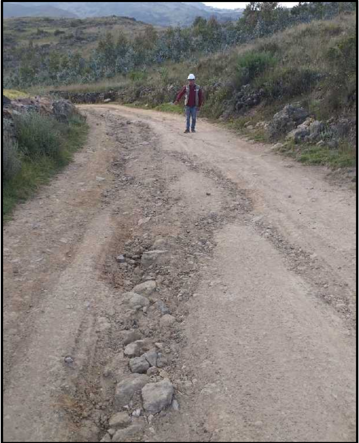
Carretera en mal estado, presenta zanjas debido a las intensas lluvias y al no contar con sus respectivas cunetas al mismo tiempo se puede apreciar pendientes que superan el 10%.
