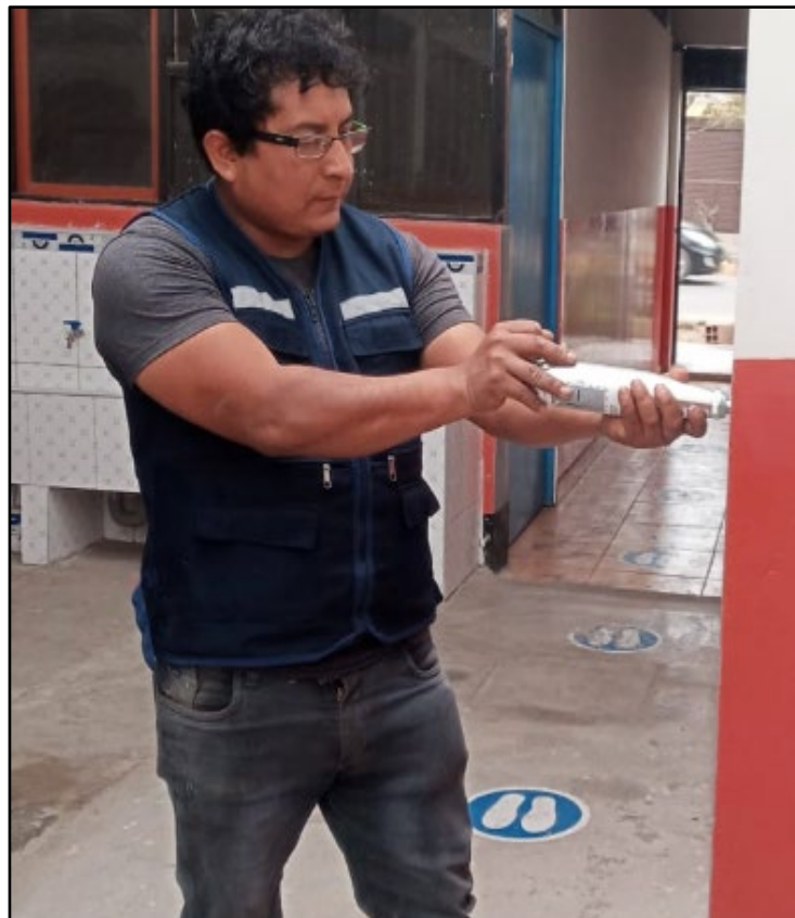
Foto 14: Aplicación de en la columna
