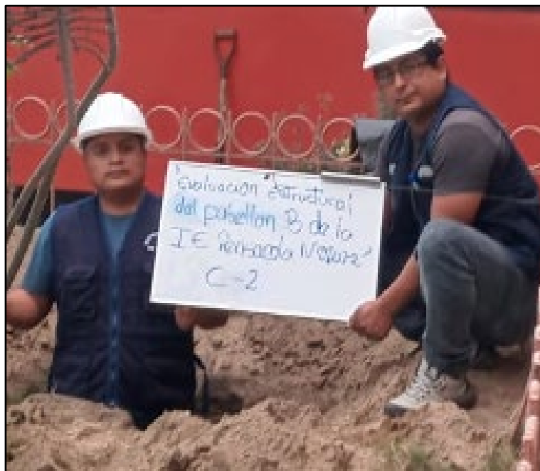
Foto 03: Excavación de calicata 02
