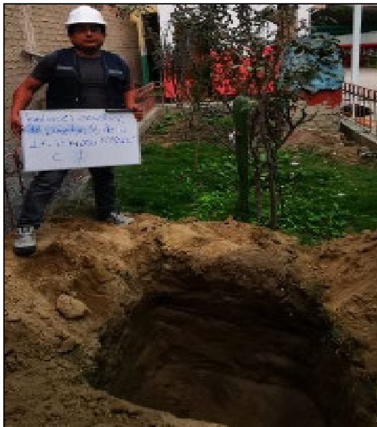
Foto 02: Excavación de calicata 01
