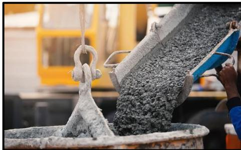
“El concreto es la mezcla de agua, agregados y cemento. Una vez que se forma la mezcla, se pueden agregar varios tipos de aditivos. El objetivo es arreglar sus propiedades del concreto como la tolerancia a fallas, la impermeabilidad, la durabilidad y la trabajabilidad sin afectarlas.” (ABANTO, 2017)
