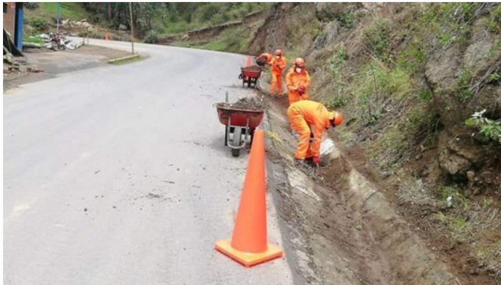
Figura 08: Mantenimiento de carreteras
