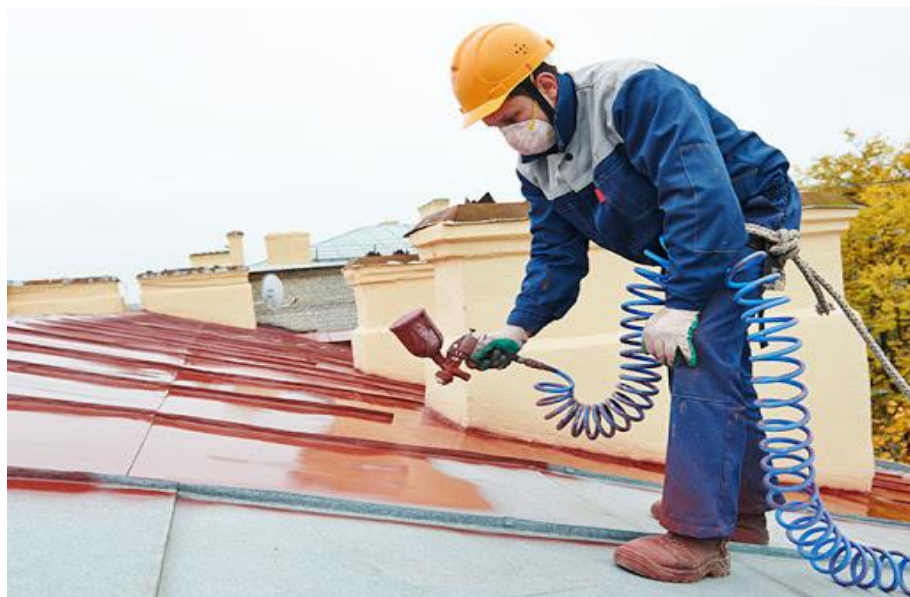
Figura 07: Mantenimiento de techos
