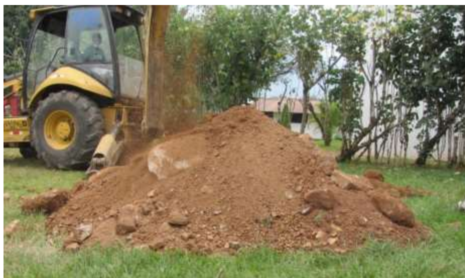
Foto N°7: Excavación de calicata C-1.
