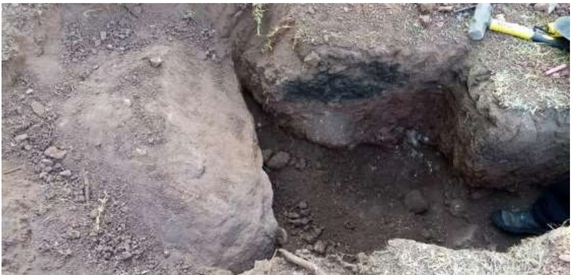
Foto N°2: Presencia de bolonería.
