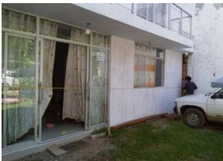
Foto N°4: Medición de la sala.
