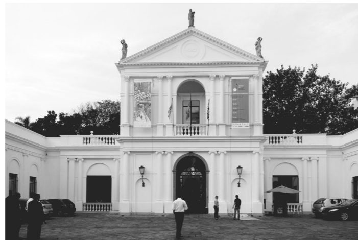
Figura 6: Wladimir Alves de Souza. Solar dos Prado, atual Museu da Casa Brasileira. São Paulo, 1945. Foto do autor.
