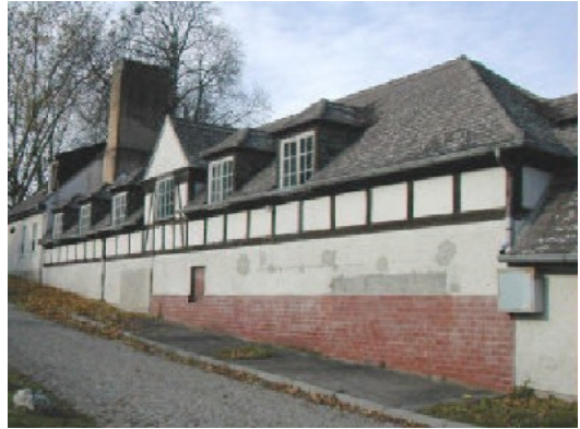
Südansicht Garage und Wagenremise heute
