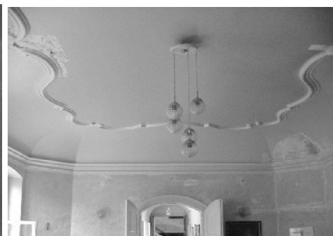
Stuckarbeiten im Speisezimmer
