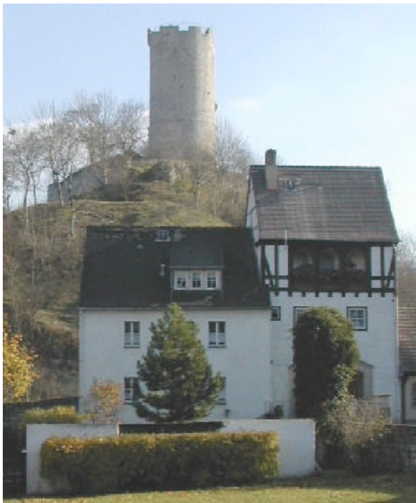
Westansicht Torhaus mit Burg Saaleck
