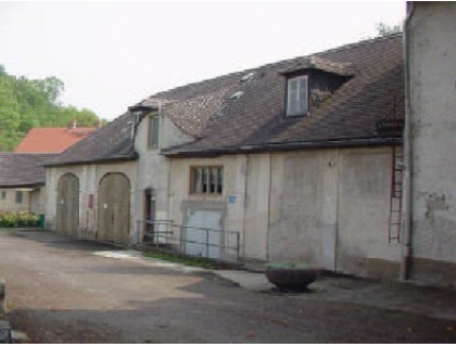
Nordansicht Garage und Wagenremise heute
