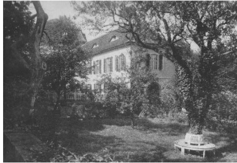
Ostansicht Anbau nach dem Umbau
