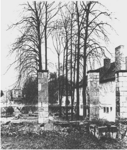
Die oberste Stützmauer Ostansicht
