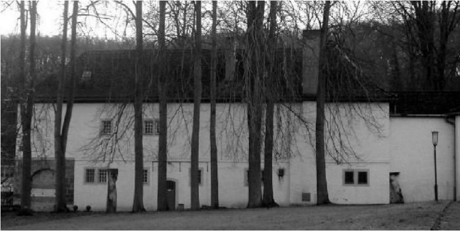
heutige Nordansicht Anbau mit Verbindung zum Haupthaus
