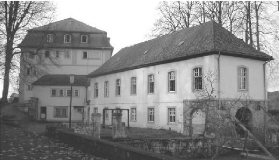
Ostansicht Haupthaus mit Anbau
