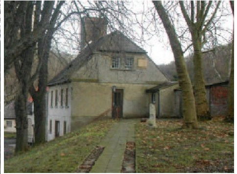
Westansicht Wohnhaus heute
