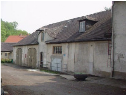
Nordansicht Garage und Wagenremise heute
