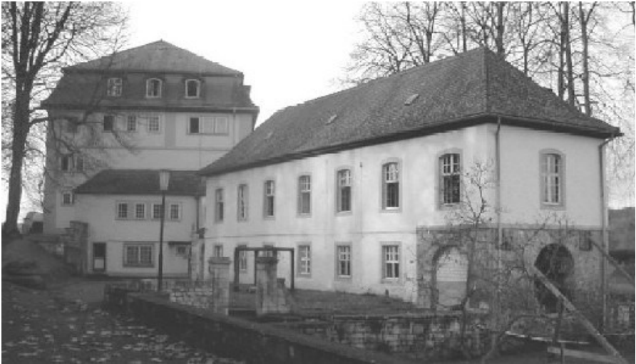
Ostansicht Haupthaus mit Anbau
