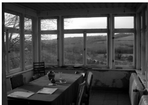
Die Veranda im Westteil des Hauses heute
