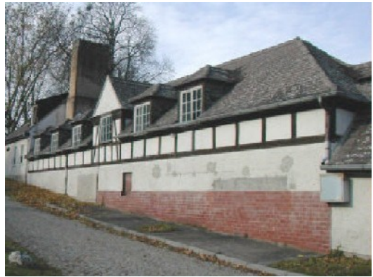
Südansicht Garage und Wagenremise heute
