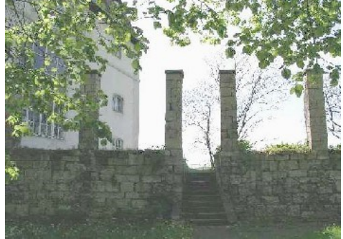
Die oberste Stützmauer mit Treppe Westansicht
