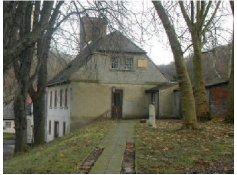
Westansicht Wohnhaus heute
