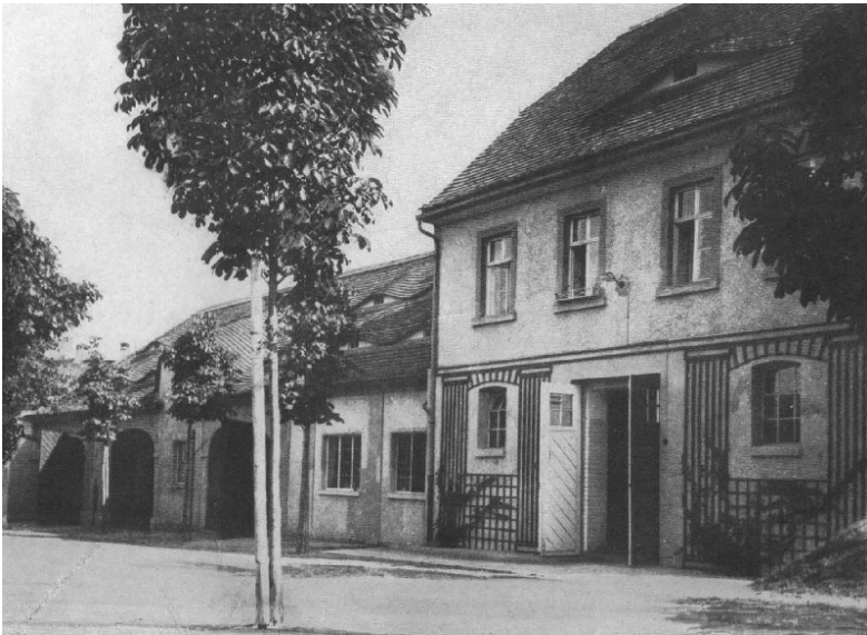
Nordansicht Garage, Wagenremise und Pferdestall zur Zeit Schultze-Naumburgs
