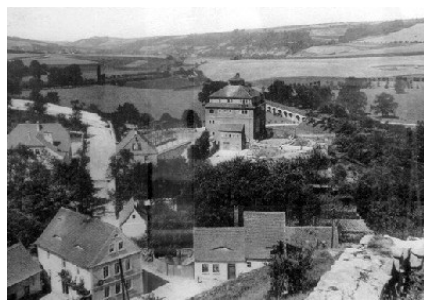
Saalecker Werkstätten im Bau
