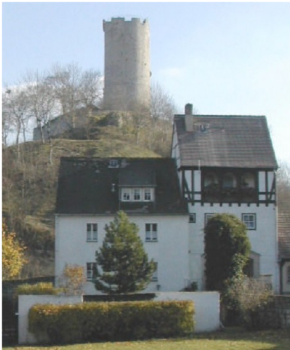
Westansicht Torhaus mit Burg Saaleck
