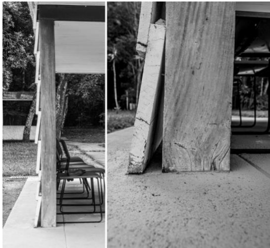
Figura 6. Vista lateral do contraventamento em tábuas na empena do Catetinho. Fotos: M. M. Mennucci, 2017.
