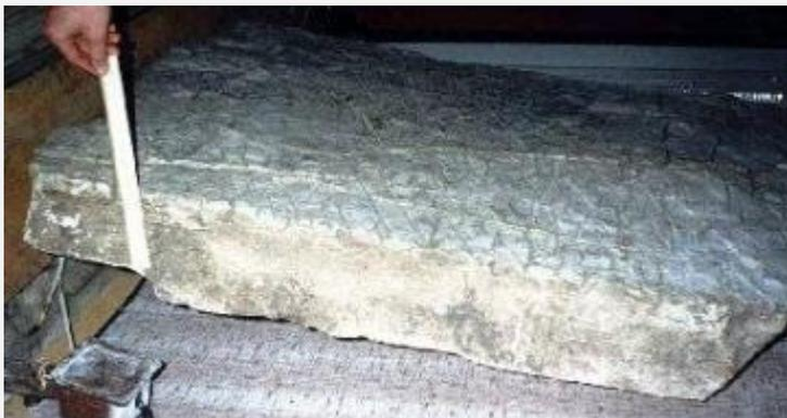
Abb. 7: Diese Seitenansicht zeigt die Oberflächenbeschichtung des Steins
