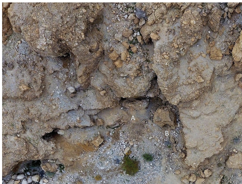
Fig 15. Area dell'ingresso. Foto aerea (GS)
