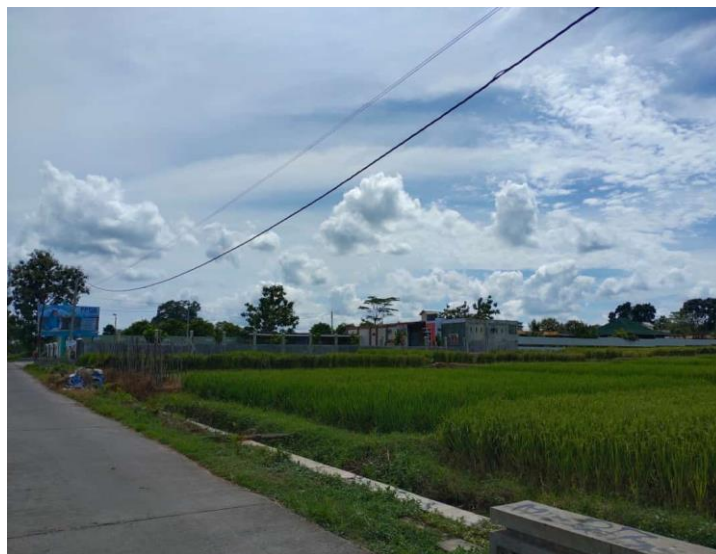
Gambar 1.1 Salah Satu Bangunan Sekolah di Kecamatan Jatinom
