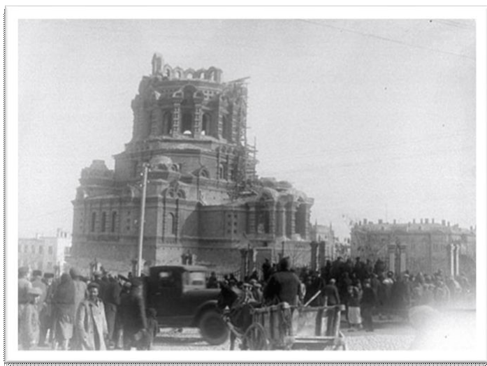
Собор Александра Невского в Баку в процессе деконструкции.
