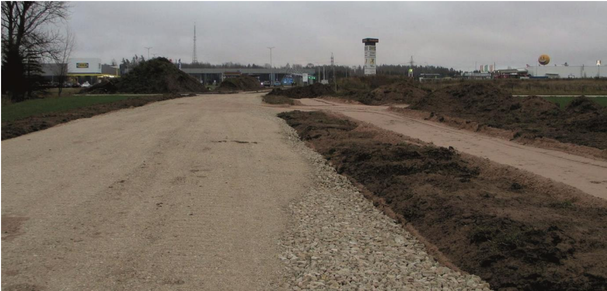
Joonis 5. Tehismulla rajamine tee pervele. Foto: R. Kõlli.
