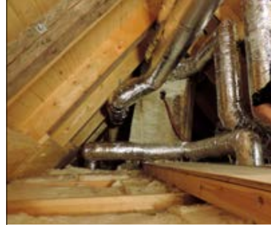
Installatør samler ventilation på kipløft i Mern.
