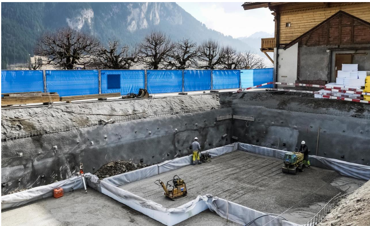
Abbildung 3: eTank im Bau. Die Heizspiralen sind am rechten unteren Bildrand sichtbar. (Gempeler & Kleptcha, 2010)
