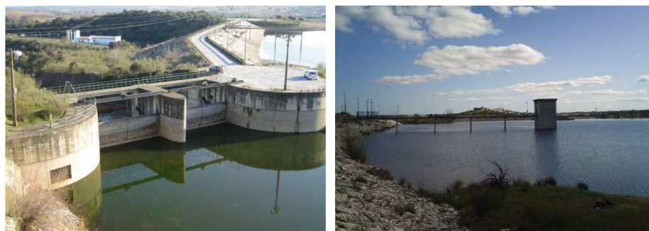
Figura 3.4. Barragem do Lucefecit: Fotos dos descarregadores de cheia, coroamento e do paramento a montante (lado esquerdo) e da tomada de água (lado direito), retirado de DGADR (2014).
