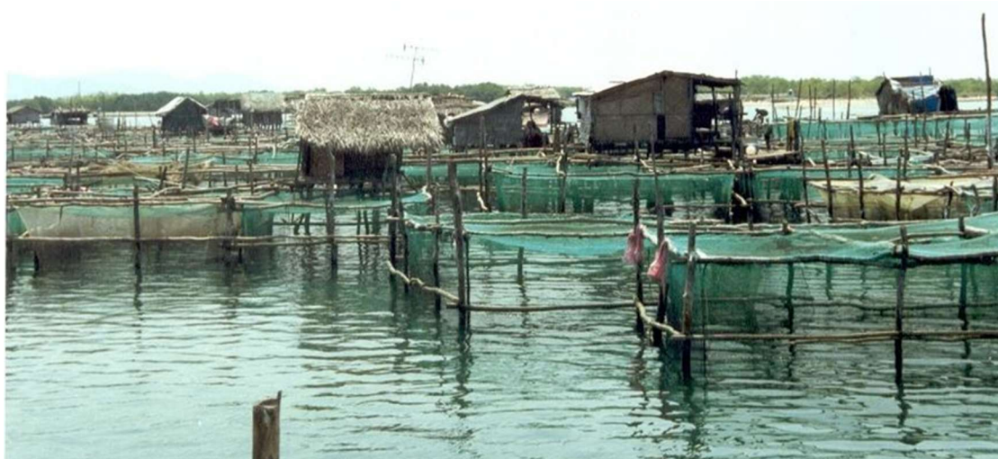
Εικόνα 4: Σταθεροί ιχθυοκλωβοί στο Βιετνάμ, κατασκευασμένοι από ξύλο (Πηγή: Nguyen, 2009 )
