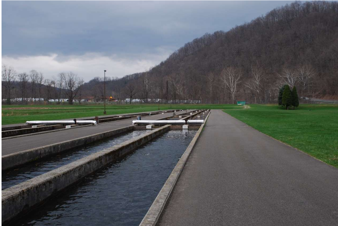
Εικόνα 3: Δεξαμενές Raceways σε ιχθυογεννητικό σταθμό της Δυτικής Βιρτζίνια των Η.Π.Α (Πηγή: Brian M. Powell, <a href="https://creativecommons.org/licenses/by-sa/3.0" title="Creative Commons Attribution-Share Alike 3.0">CC BY-SA 3.0</a>, <a href="https://commons.wikimedia.org/w/index.php?curid=4450837">Link</a>)
