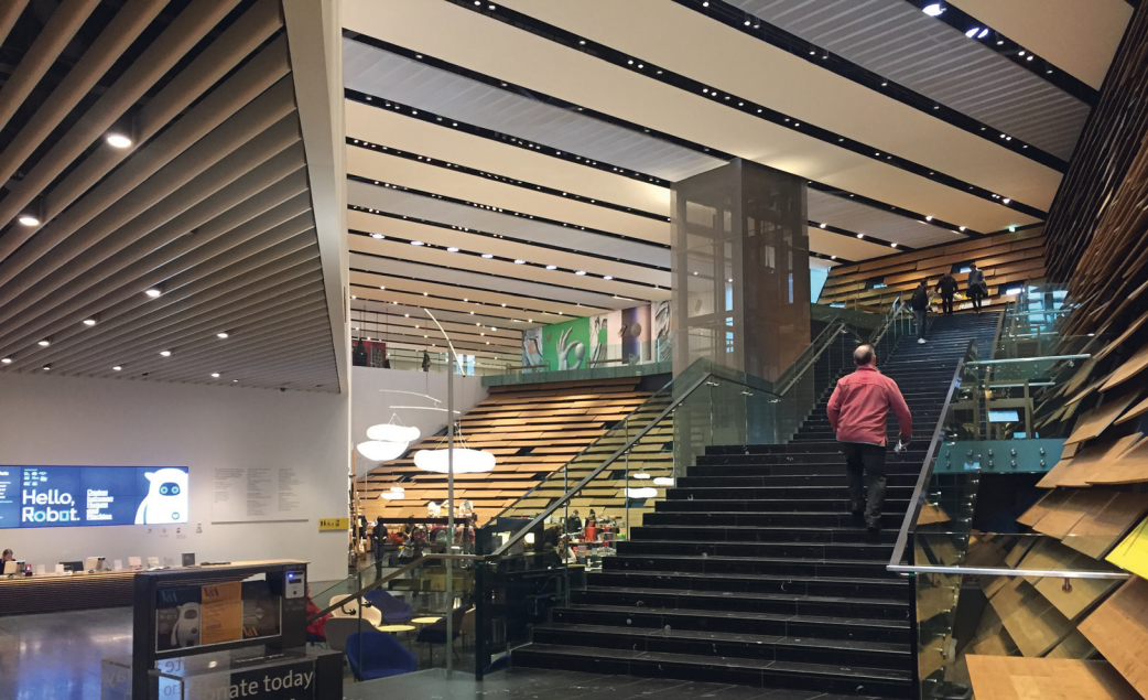
Kuva 13. Museon pääaulassa toistuu julkisivun muotokieli osana akustoivia elementtejä: alakatot ja seinäverhous. Sivun valokuvat Elina Turpeinen 2019.
