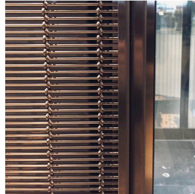
Kuva 15. Hissikuilua ympäröivä metalliverkkoverhous ja taustalla näkyvä hissikorin sisäpuoli.
