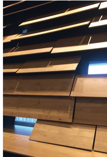
Kuva 14. Seinien puuverhous ja kiinnitystapa.
