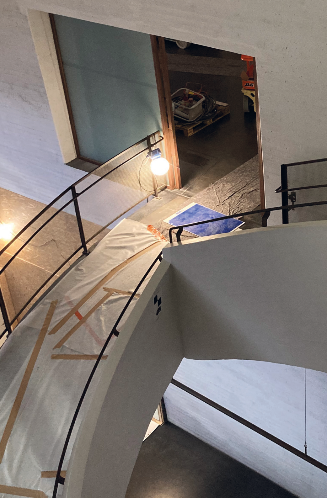
Kuva 2. Korjausrakentamisen ja rakennetun ympäristön vaalimiseen on kiinnitetty huomiota osana kansallisia ja kansainvälisiä julistuksia. Peruskorjauksessa olemassa olevaa suojellaan myös konkreettisesti pintojen suojaamisella. Kiasma, Spagettiportaikko, 3. kerros. Valokuva Elina Turpeinen 2022.
