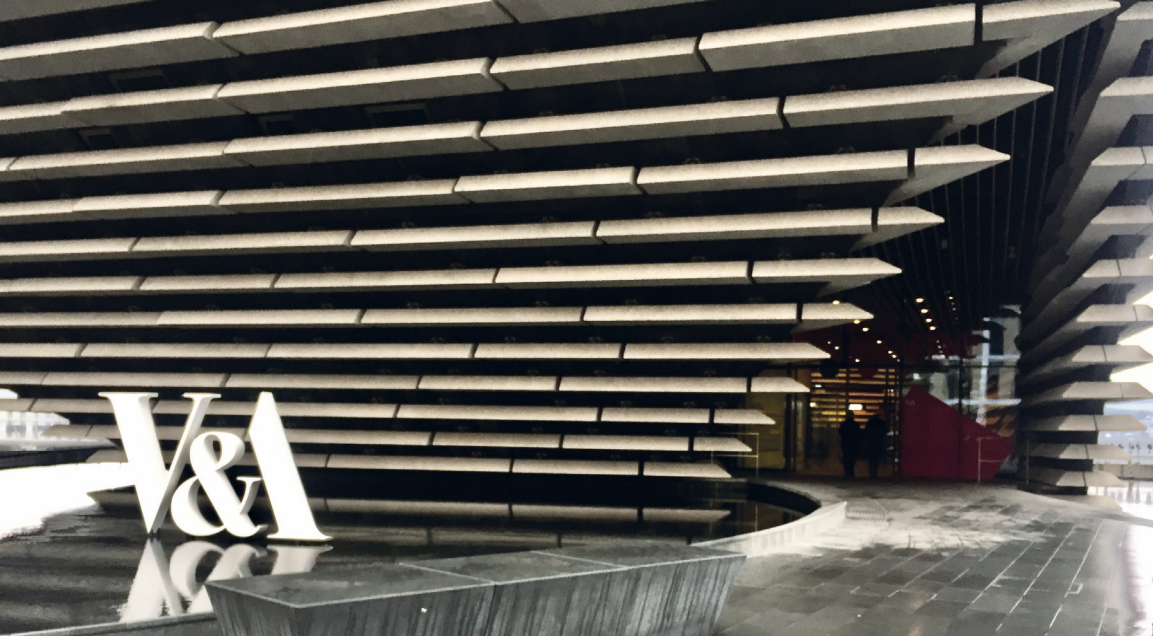
Kuva 12. Skotlannin designmuseum V&A Dundee, julkisivuverhoukseen koostuu betonielementeistä ja pääsisäänkäynti mukailee purjealauksen keulan muotoa. Suunnittelutarkkuretti Kengo Kuma. Valokuva Elina Turpeinen 2019.
