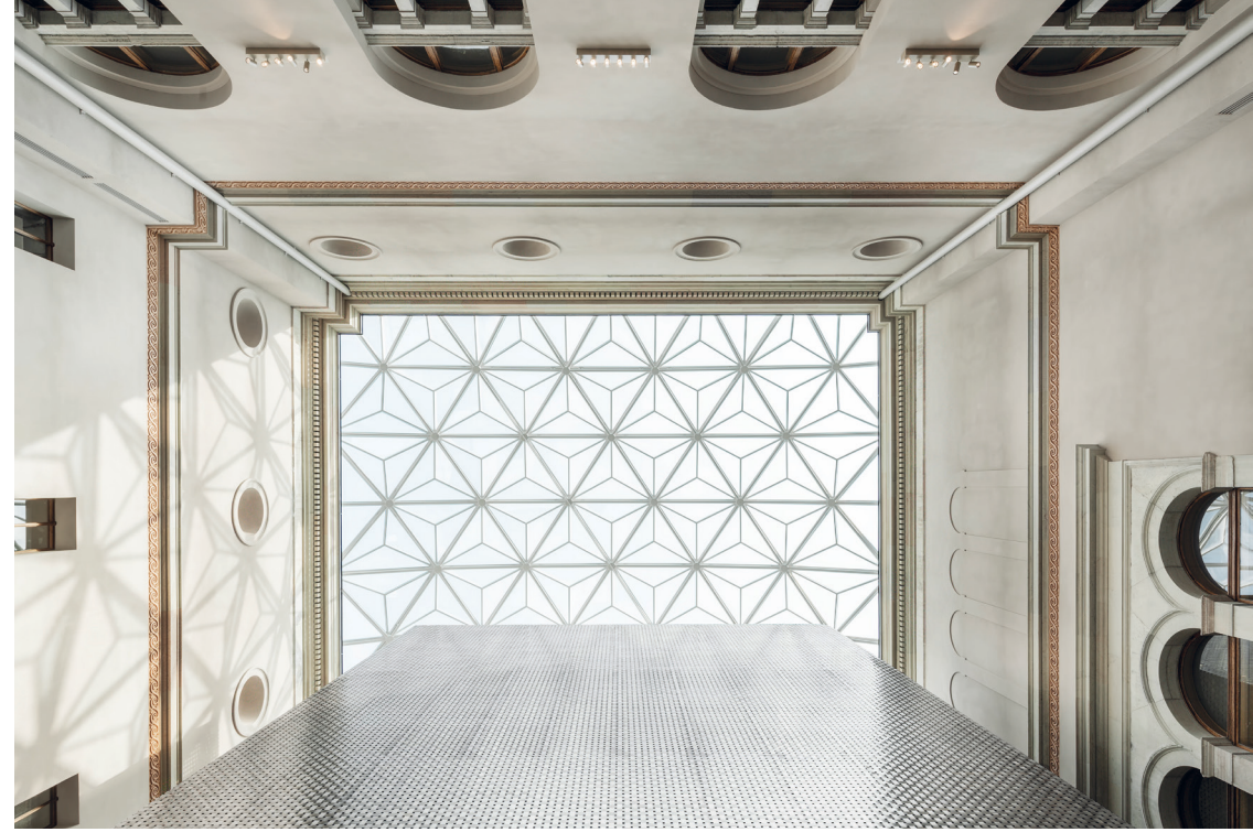
Kuva 42. Katettu sisäpiha ja monoliittimaisena kohoava metalliverkkoverhoiltu uusi hissiyhteys. Nationalmuseum, Tukholma. Valokuva André Phil 2018.
