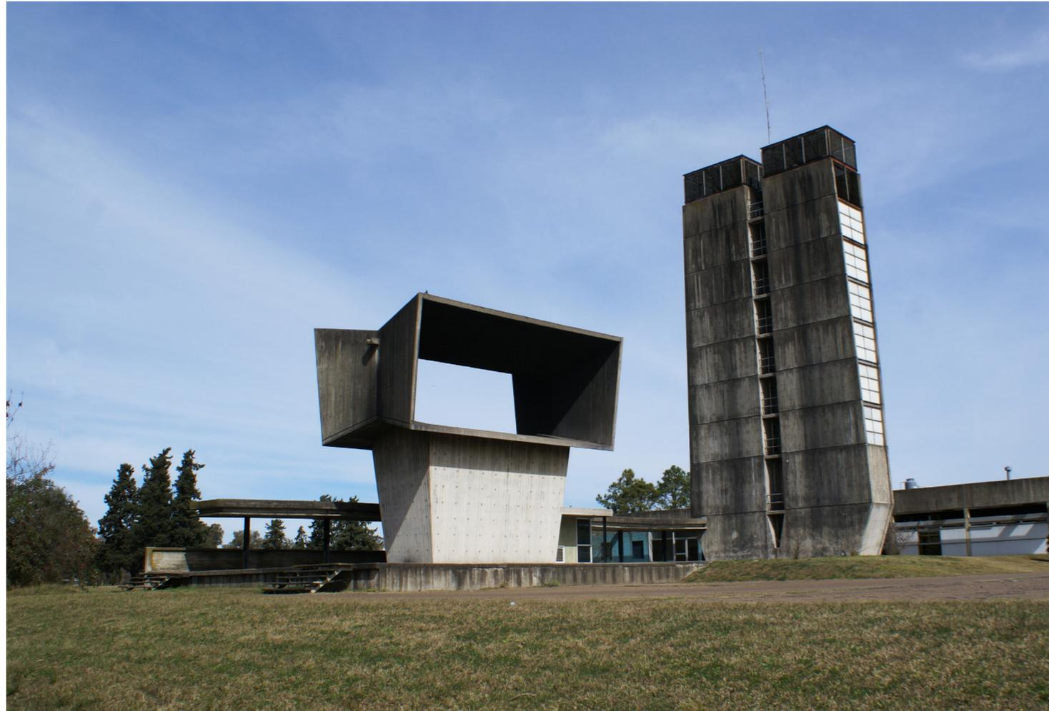
Figura 11: Torres de ventilación en el lado Paraná.
