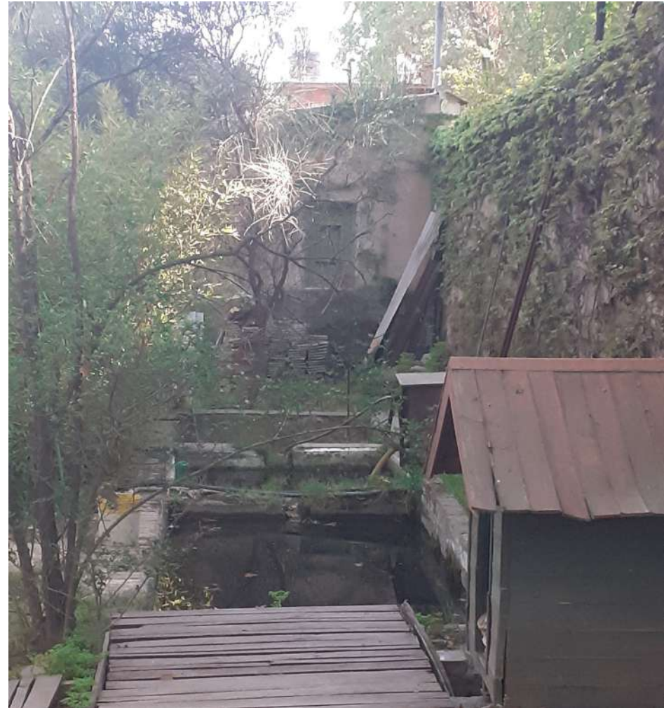
Pileta clarificadora para el suministro de agua a la vivienda. Foto: Verónica Cremaschi
