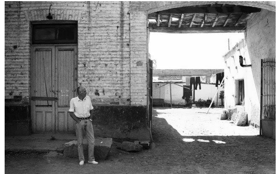
Antiguo frente de la calle Viamonte. 1990c. Actualmente demolido. Foto: Cachilo Púrpura
