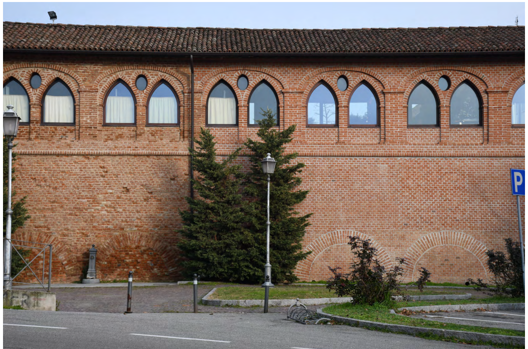
10. Orio Litta (Lodi), grangia benedettina, in evidenza la parte ricostruita dopo il crollo
