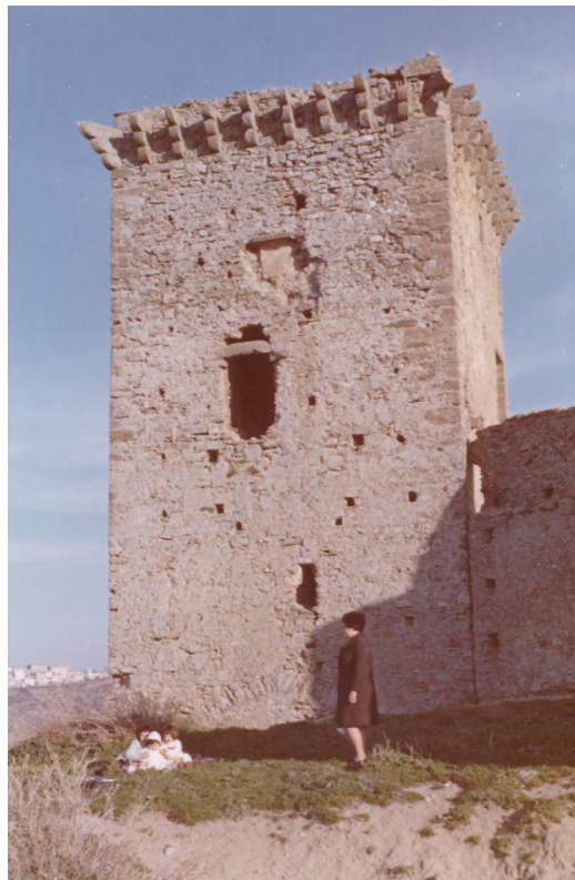
Fig. 4 – Ferrandina (MT), Castello di Uggiano. Una delle torri crollate, ante 1973 (archivio privato R. Tremamunno).
