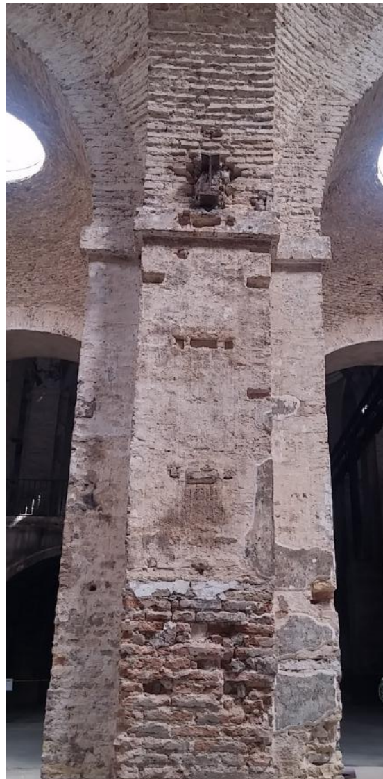
Fig. 14 Interno della Fundición Mayor dopo l'intervento di restauro conservativo.
