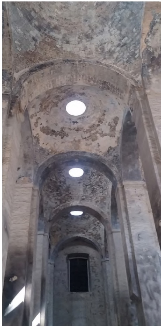
Fig. 12 Interno dell'edificio Taller de Fundición Mayor composto da moduli voltati su pilastri cruciformi illuminati da lucernari.
