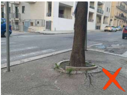
Albero posto subito dopo l'attraversamento e mancanza di rampa per disabile
