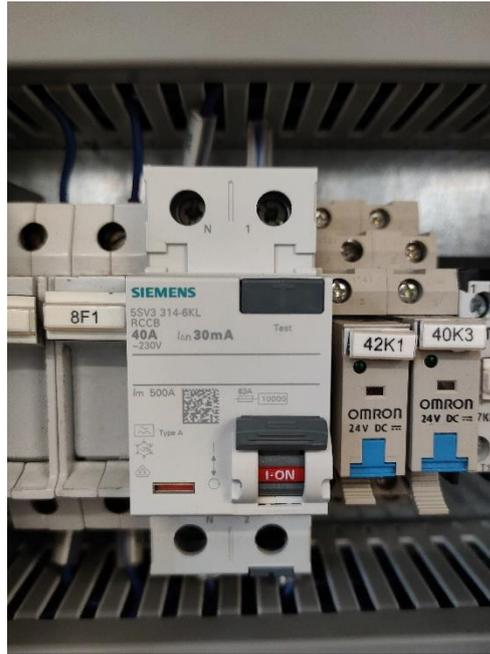
Figura 55 Interruptor diferencial(encendido) que hará la función de "Muting". (Fuente propia)
