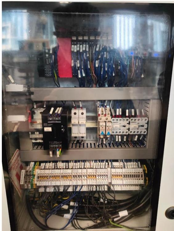
Figura 45 Armario eléctrico con el PLC NX-SL3300. Incluye todo el cableado que había previamente. (Fuente propia)
