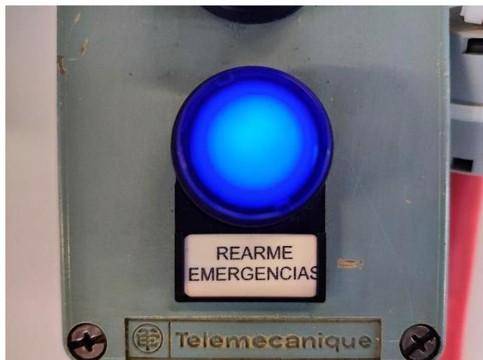
5. Si después de mantener pulsado el botón no se apaga, el indicativo es porque algún elemento del sistema de seguridad está en estado "seguro", es decir, hace falta solucionar el problema con el elemento.
