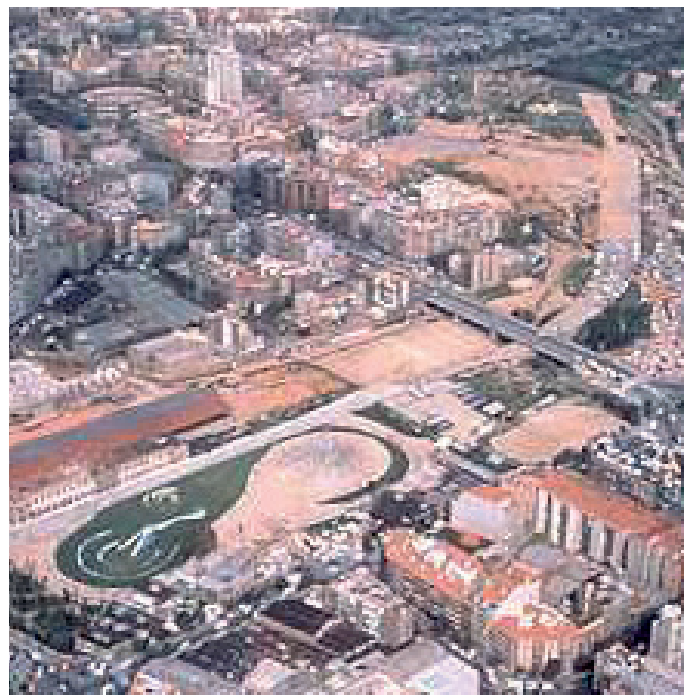
Fig 15. Parc de l'Estació del Nord en construcció. Font d'arxiu publicspace.org
