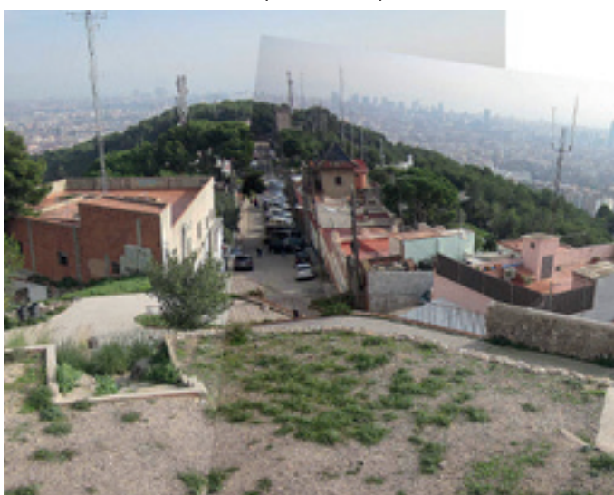
Fig 56 . Vista del Carrer Marià Lavèrnia abans de la intervenció. Font Bosch Capdeferro arquitectura
