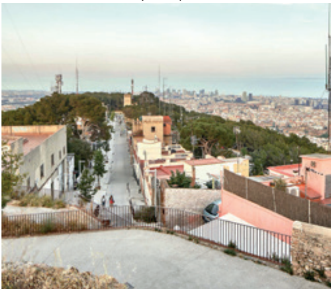
Fig 55 . Vista del Carrer Marià Lavèrnia després de la intervenció. Font Bosch Capdeferro arquitectura
