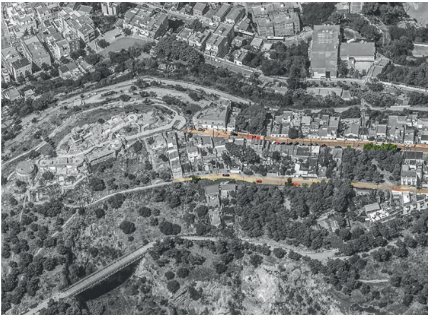
Fig 52. Vista aèria dels carrers Marià Lavèrnia i Lavèrnia. Imatge manipulada sobre el material de Bing Maps
