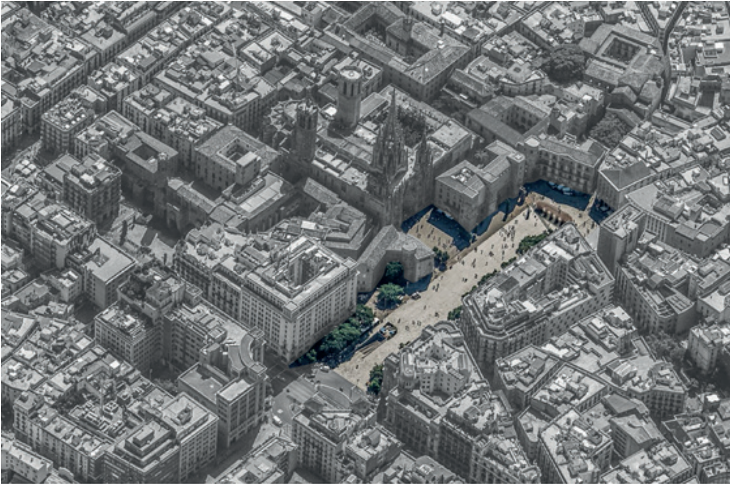
Fig 9. Vista aèria de la Remodelació de la Plaça de la Catedral. Imatge manipulada sobre el material de Bing Maps
