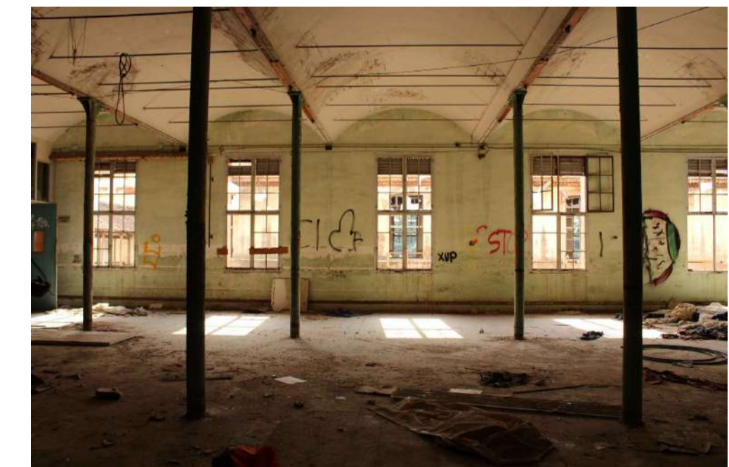
F.14 Interior de Filatures volum secundari. Voltes i pilars de forja. Altura lliure = 4,20 m
