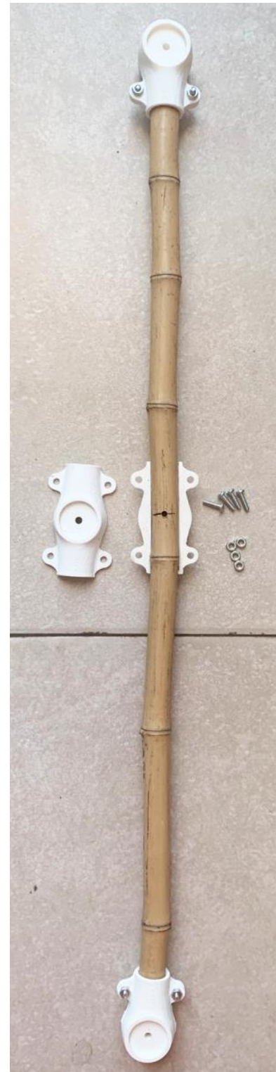
Figura 10.70 Ensamble barra de bambú con abrazaderas. Fuente: Elaboración del autor
