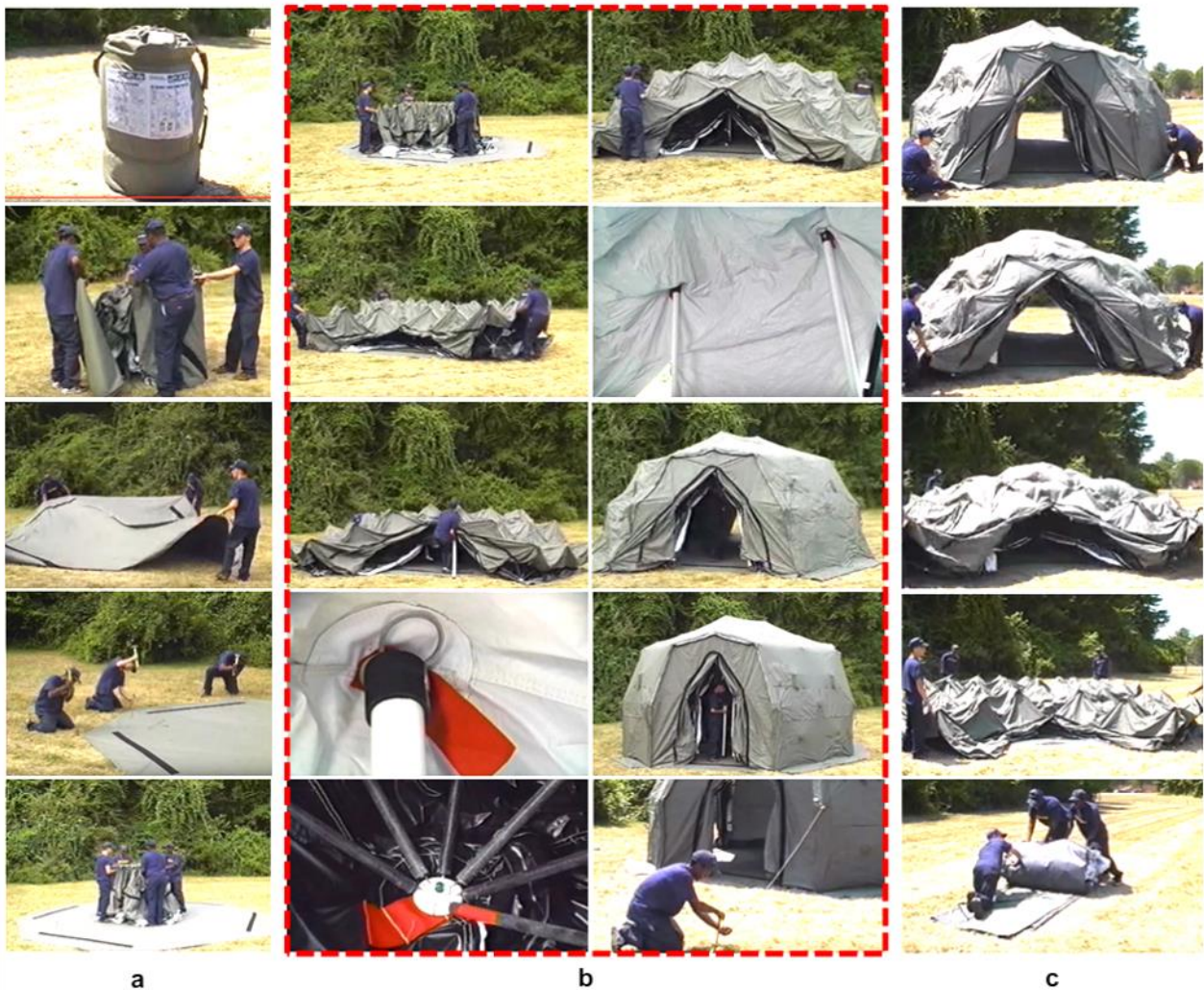
Figura 2.66 Proceso de despliegue, montaje y desmontaje refugio militar [108].
