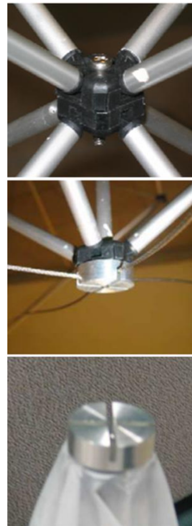
Figura 2.156 Detalles nudos. Articulación de barras. Sujeción de cable para rigidizar la estructura en estado desplegado. Sujeción del textil [53]
