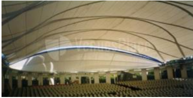
Figura 2.145 Cubierta del Auditorio de la Alameda en Jaén, España. Fuente https://www.venuesplace.com/es/4753-auditorio-municipal-de-la-alameda Recuperado [02/12/2018]
