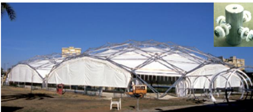
Figura 2.32 Exterior de la piscina en construcción. Nodo tipo para cuatro barras [2].
