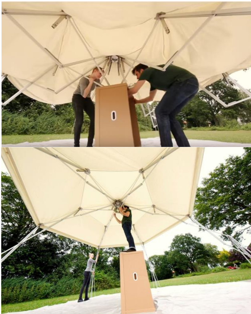
Figura 2.72 Proceso de despliegue. Etapa de elevación de la cúspide con fuerza manual. [123].
