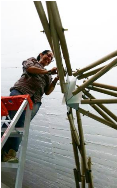
Figura 7.41 Montaje nodo en escenario desplegable. Fuente: Elaboración del autor
