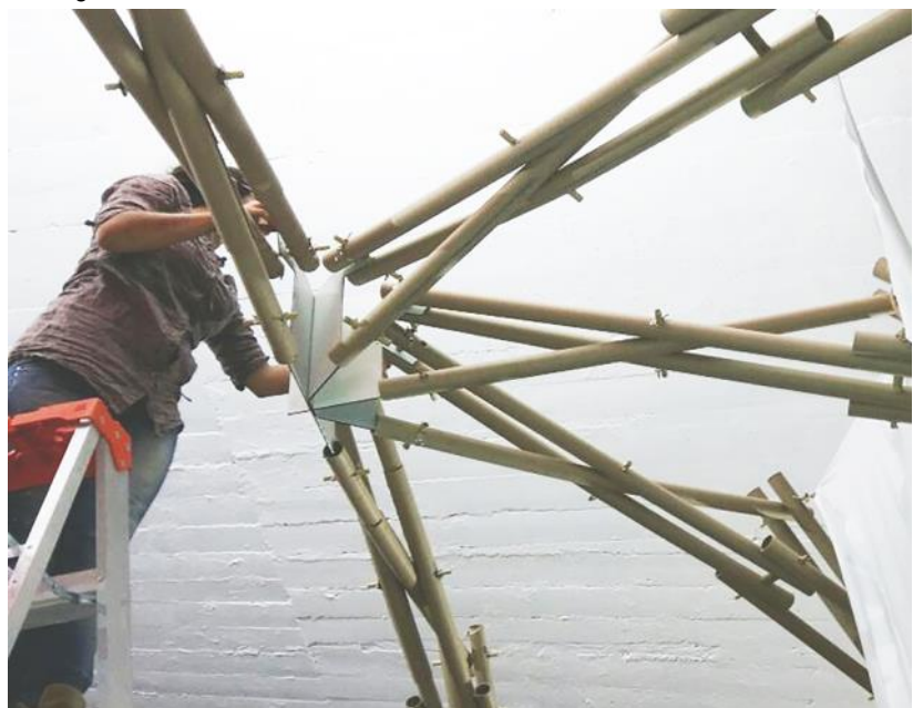
Figura 7.45 Fijación del nodo a la cúspide del escenario Fuente: Elaboración del autor
