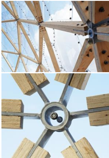
Figura 7.11 Nodo para domo geodésico en madera.
