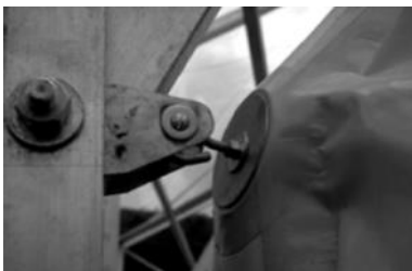
Figura 2.37 Anclaje para colgar la membrana [36].
