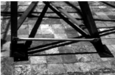
Figura 2.36 Elemento de bloqueo del movimiento en las bases [36].
