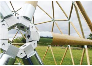
Figura 7.10 Nodo para domo geodésico en bambú.
