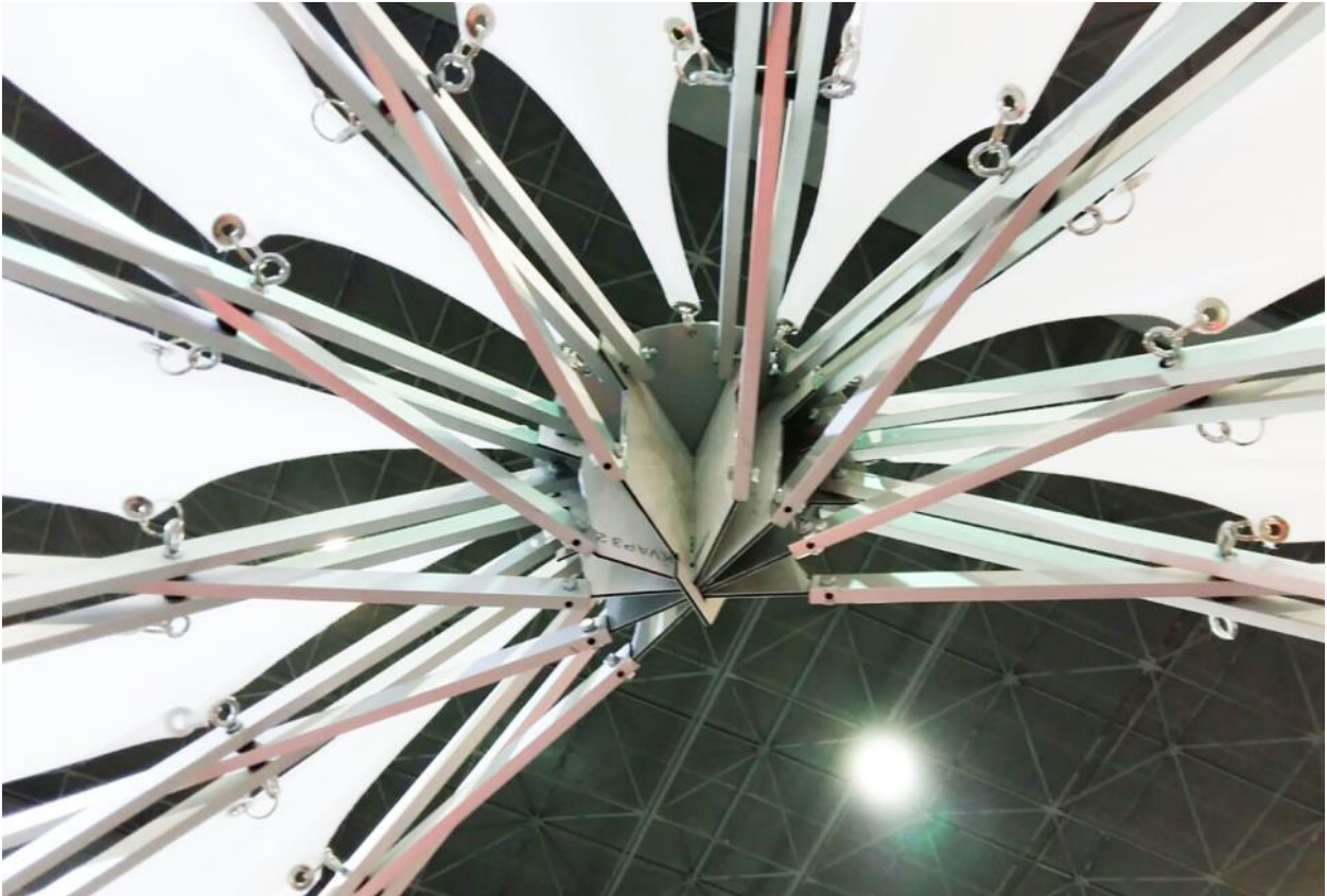
Figura 7.49 Componentes y ensamble nodo para stand desplegable
