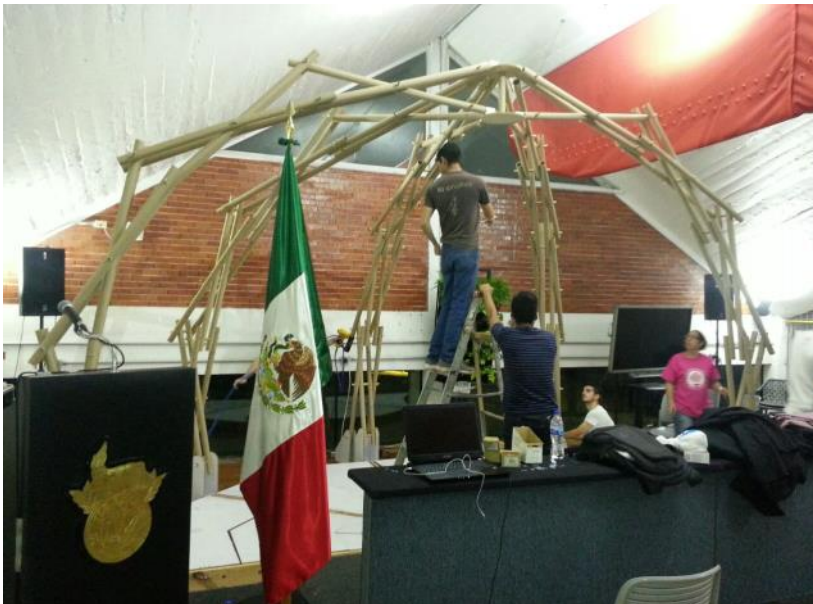
Figura 2.59 Prototipo a escala de un escenario desplegable. Tubos de cartón, bases y suelo en madera (material reutilizado). Fuente: Elaboración del autor
