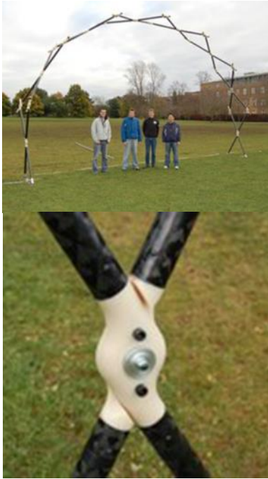
Figura 2.55 Arco desplegable para propuesta de refugios de rápido montaje, Detalle de nudo, articulación central [84].
