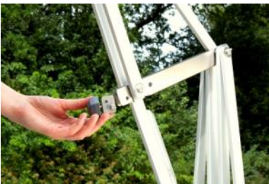
Figura 2.69 Sistema de rigidización y bloqueo del movimiento. Arcos desplegables. [123].
