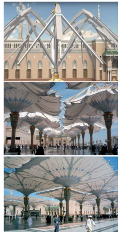
Figura 2.131 Parasol desplegable de 17 m x 18 m para las áreas de rezo en la Meca. Mezquita del Profeta de Medina. Arabia Saudita, 1991. Fuente http://www.sl-rasch.com Recuperado [12/11/2018]
