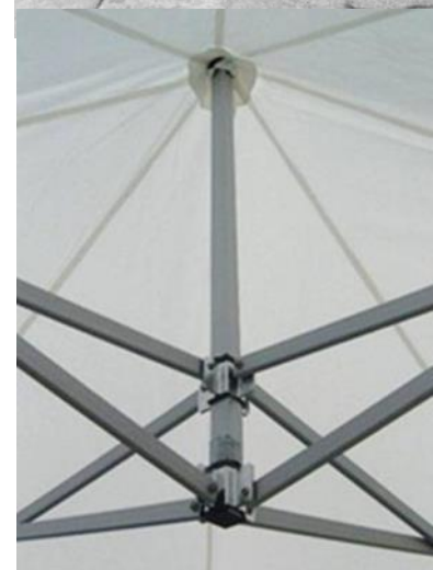
Figura 2.172 Mástil para general punto alto en la cubierta Fuente
