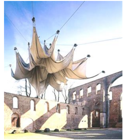
Figura 2.135 Cubierta textil retráctil. Teatro al aire libre Bad Hersfeld. 1968 © Foto: Bad Hersfeld Festival.
