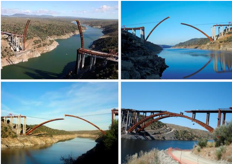
Figura 6.6 Montaje puente Arcos de Alconétar, construcción por abatimiento. Fuente: https://abc-utc.fiu.edu/mc-events/construction-methodology-for-alconetar-arch-bridges-in-spain/?mc_id=350 Recuperado [03/03/2019]
