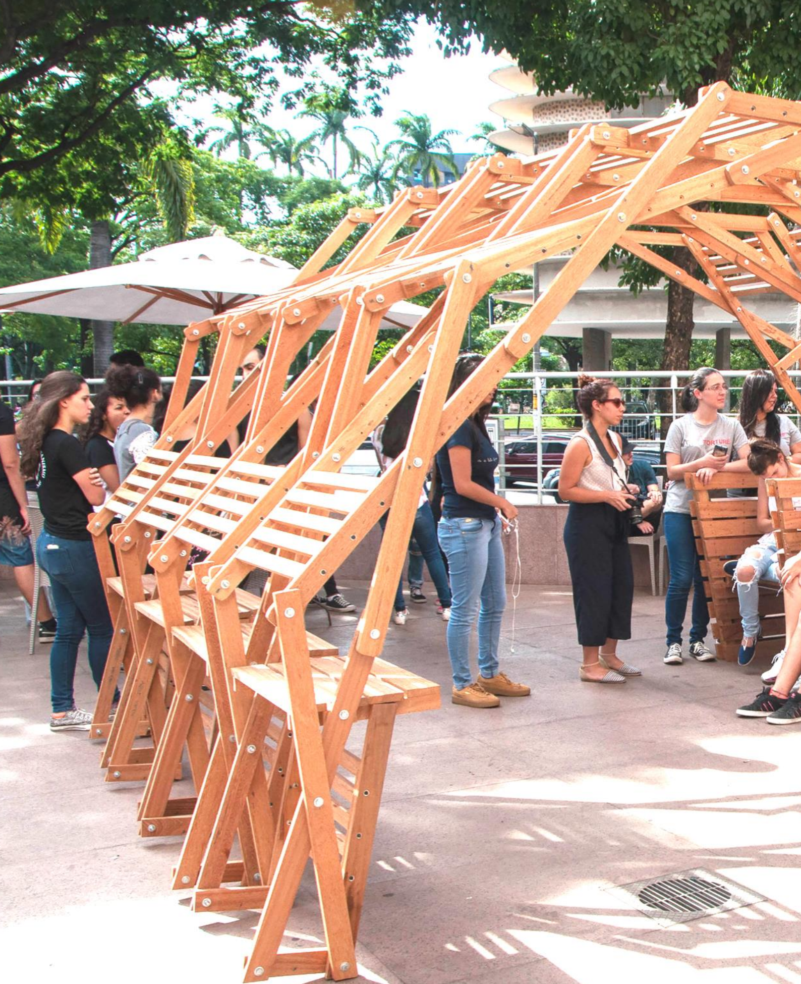
Pabellón Xuê . Mención de honor. Premio latinoamericano Ibramem Amata de Arquitectura en Madera, categoría estudiantes, 2018, promocionado por la Universidad de Sao Paulo dentro del marco del III Congreso Latinoamericano de estructuras de madera y el XVI Encuentro brasileiro de maderas y estructuras de maderas [87]. Fotografía Laura Costa.
