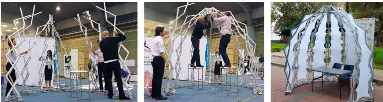
Figura 6.15 Proceso de montaje en prototipos de domos desplegables. a) Escenario. Arcos sistema tipo tijera con tubos de cartón. b) Stand. Arcos sistema tipo tijera con perfiles rectangulares en aluminio. Más información capítulo diez. Prototipos. Fuente: Elaboración del autor.
