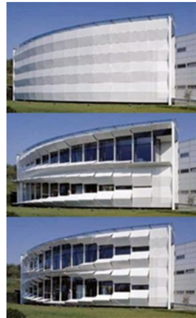
Figura 2.110 Fachada plegable edificio Kiefer Technic Showroom. Fuente: http://www.plataformaarquitectura.cl/02-35147/fachada-kiefer-technic-showroom Recuperado [17/07/2018]
