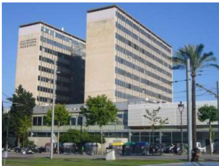
Figura #2: Fachada principal de la ETSEIB
