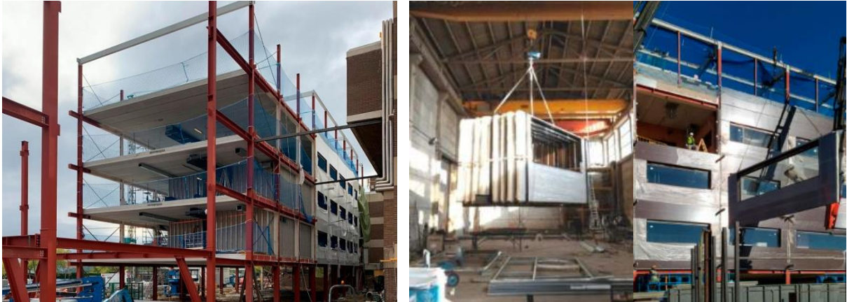
Fotografía 4.2 Proceso constructivo del Edificio I-COVID COMPACT Fuente: https://construccionsbim21.com/blog/5-hospitales-20-semanas/
