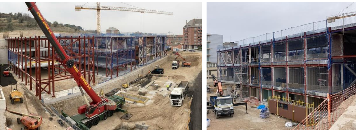
Fotografía 4.4 Estado actual - EHP Hospital General de Granollers Fuente: Constructora (Coordinación LEAN-BIM)
