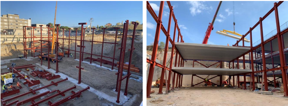
Fotografía 4.3 Proceso constructivo - EHP Hospital General de Granollers Fuente: Propia y Constructora (Coordinación LEAN-BIM)
