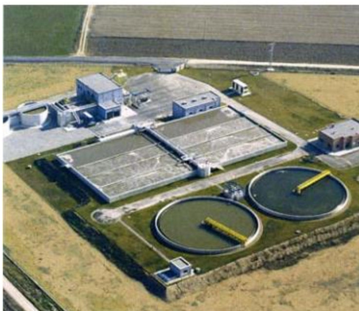
Figura 27. Vista aèria de l'EDAR Fondarella
