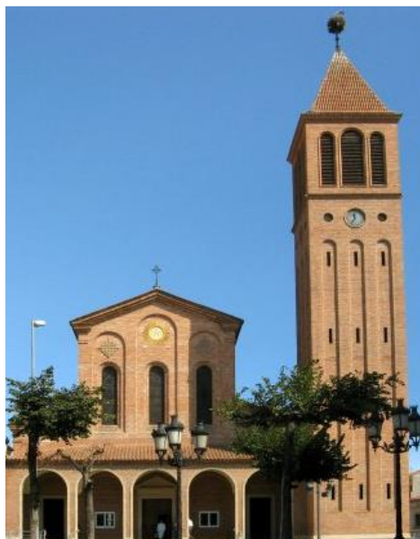
Figura 5. Vista de la façana principal de l'església de Sant Jaume
