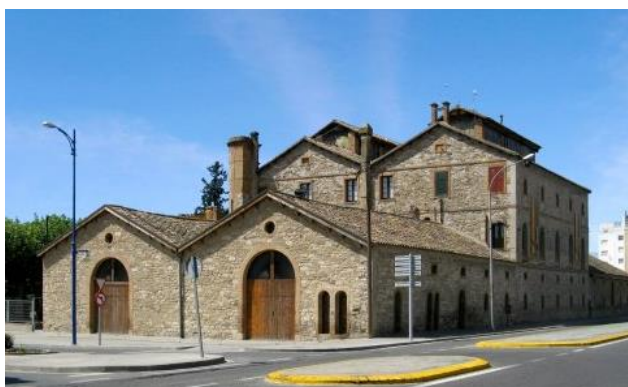
Figura 5. Vista de la façana principal de la Casa Canal
