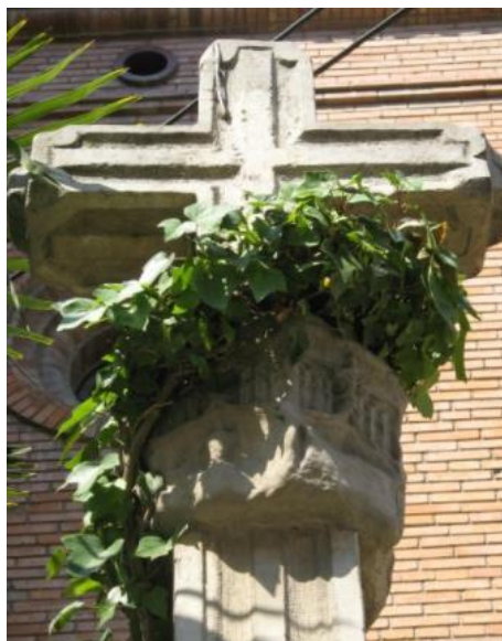
Figura 6. Vista frontal de la Creu de Terme
