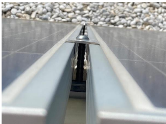
Figura 77 – Pinça conductora entre panells.
