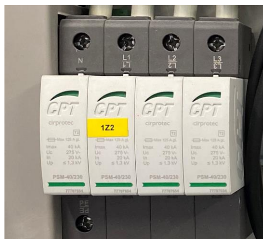
Figura 66 – Proteccions Sobretensions AC.
