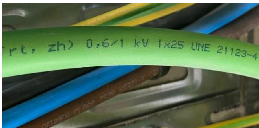
Figura 74 – Conductor terra amb secció indicada.
