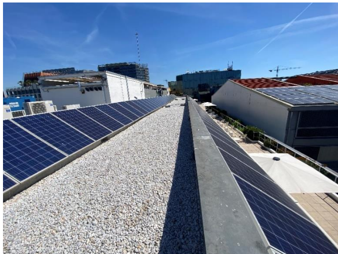
Figura 79 – Mòduls inferiors de la planta fotovoltaica.
