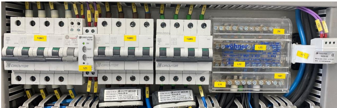
Figura 67 – Magnetotèrmics quadre AC.
