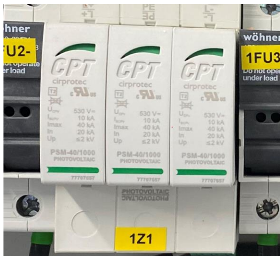
Figura 64 – Proteccions Sobretensions DC.
