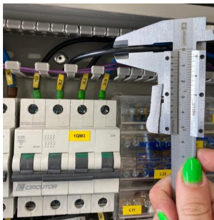
Figura 57 – Mesura amb peu de rei diàmetre de conductor AC.
