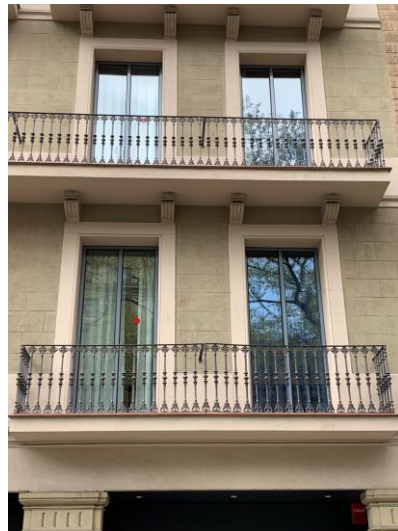
Figura 56. Zoom als nous elements constructius.
