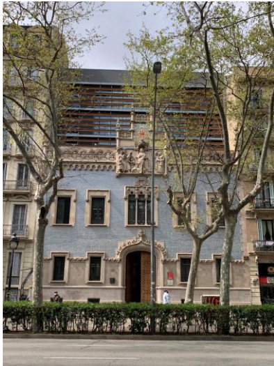
Figura 38. Imatge façana cas 15.
