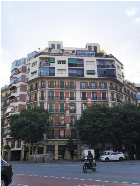
Figura 53. Exemple de remunta sortint respecte la línia de façana. Mostra de com una remunta pot ser tan agressiva que es carregui l'interès de la pròpia façana. Cas 20.
