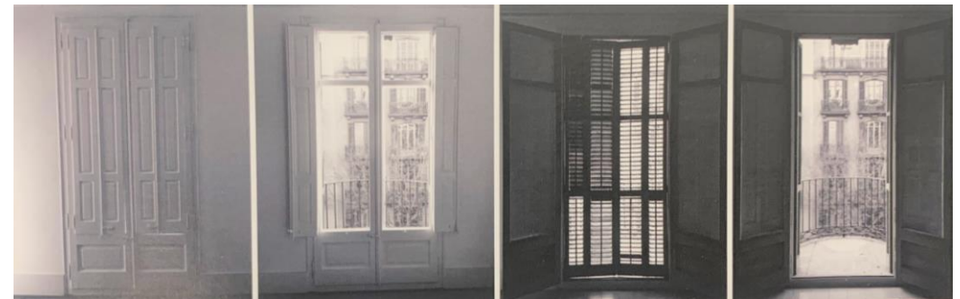
Figura 7. Conjunt d'imatges que mostren les peces que formen les obertures en façana i el seu funcionament.
