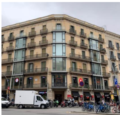
Figura 35. Imatge de l'estat actual cas 12.
