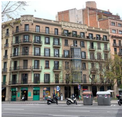
Figura 33. Imatge de l'estat actual cas 06.
