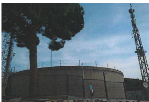
Ilustración 25. Depósito de agua en Caldes d'Estrac
