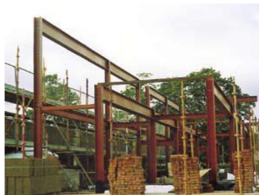
Imatge 24: Estructura d'acer procedent de Brighton
