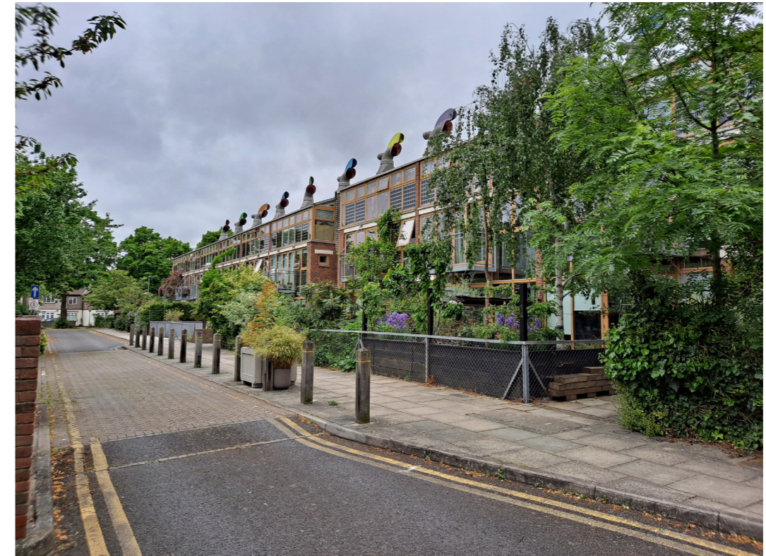
Imatge 19: Pati exterior privat exterior a cota carrer Imatge pròpia
