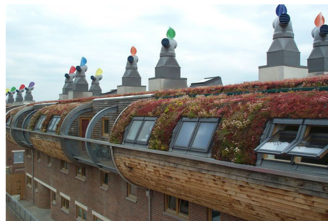
Imatge 11: Cobertes verdes amb sedum dels habitatges Imatge cedida per Bioregional
