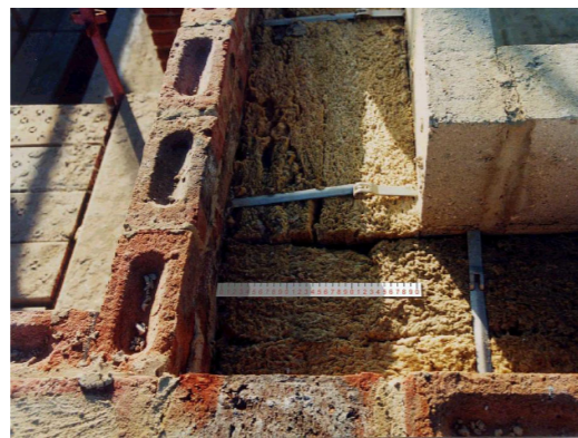
Imatge 22: Maons de Cranleigh i 300 mm d'aïllament
