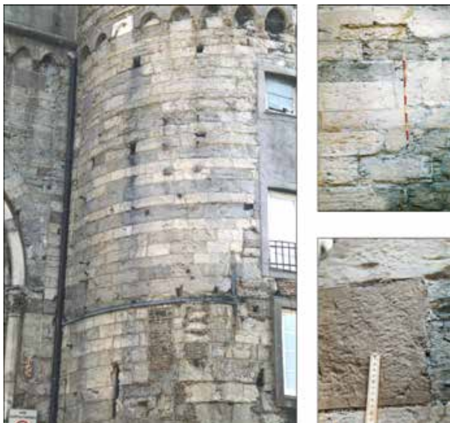
Figura 5. Porta Santa Fede di Genova. A destra particolari della muratura in opera quadrata (immagini tratte dalla presentazione di A. Cagnana dal titolo Dal muro del vescovo al muro del mercante. Trasformazioni sociali ed economiche fra XI e XII secolo nelle città della Liguria nell'ambito del convegno internazionale Il paesaggio pietrificato , op. cit. e da A. Cagnana, «L'introduzione dell'opera quadrata medievale a Genova: aspetti tecnologici e contesto sociale», Arqueologia de la Arquitectura , 4, 2005, p. 36).
