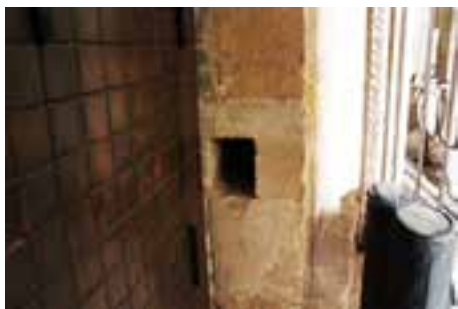
Figura 2. Mechinal de alamud en el acceso occidental (interior) de la iglesia de Santiago del Burgo (Zamora).
