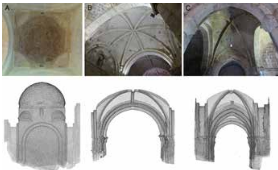
Figura 8. Cúpula de la iglesia de San Pedro de Tejada (A); Bóvedas aquitanas en la iglesia de San Lorenzo en Vallejo de Mena (B); bóveda angevina en la iglesia de Nuestra Señora de la Antigua de Butrera (C). Fotografías y modelos en 3D elaborados por la autora.
