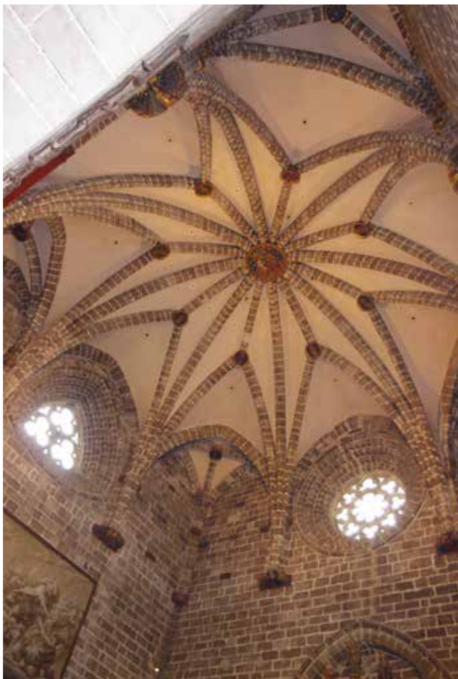
Figura 3. Bóveda estrellada del aula capítular de la catedral de València (hoy capilla del Santo Cáliz), proyectada como un alarde de geometría en tres dimensiones por el maestro Andreu Julià entre 1356 y 1369. Foto del autor.
