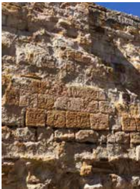
Figura 8. Tramo de muralla de ronda de Santa Ana. Sillares con marcas de cantería. Foto: Teresa Martínez Martínez.
