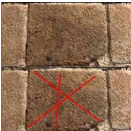
Figura 6. Sillar con marcas geométricas en Santiago El Viejo. Foto: Teresa Martínez Martínez.
