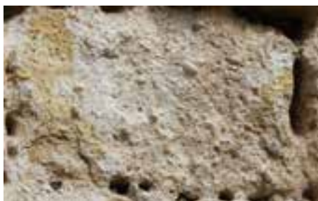
Figura 2. Detalles de la piedra local empleada en uno de los sillares de la muralla. Foto: Teresa Martínez Martínez.
