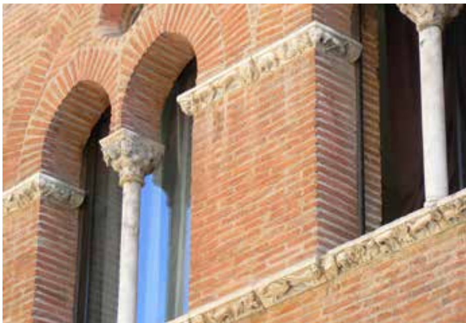
Figura 8. Casa medieval de la calle Croix-Baragnon, detalle.
