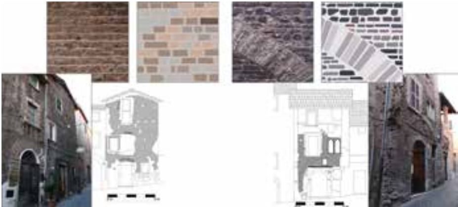
Figura 7. Due esempi di edifici realizzati con una muratura in blocchetti lapidei di tufo (Tivoli, via del Duomo, 4 e 26).
