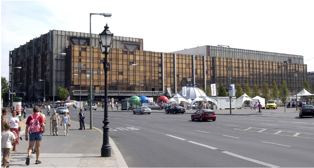
Abb. 1 Heinz Graffunder et al., Palast der Republik, Berlin, 1973–1976, Zustand nach Asbestsanierung und vor Abriss, August 2004.
