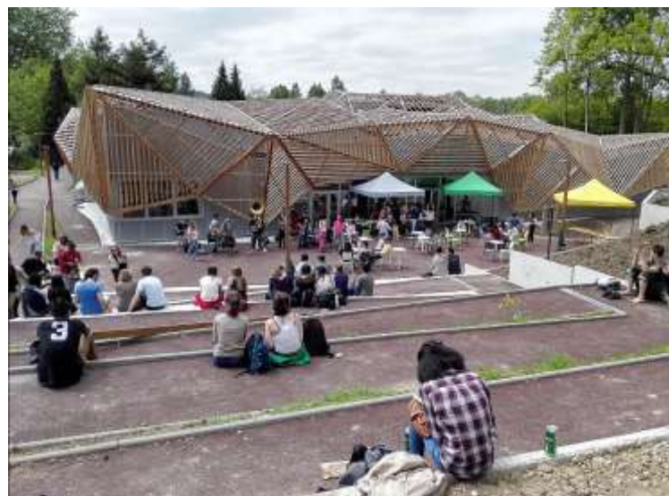
Figura N° 1: Vista de cubierta exterior y patio de caso 1
