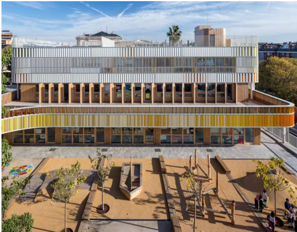
Figura N°6: Vista exterior de caso 6
