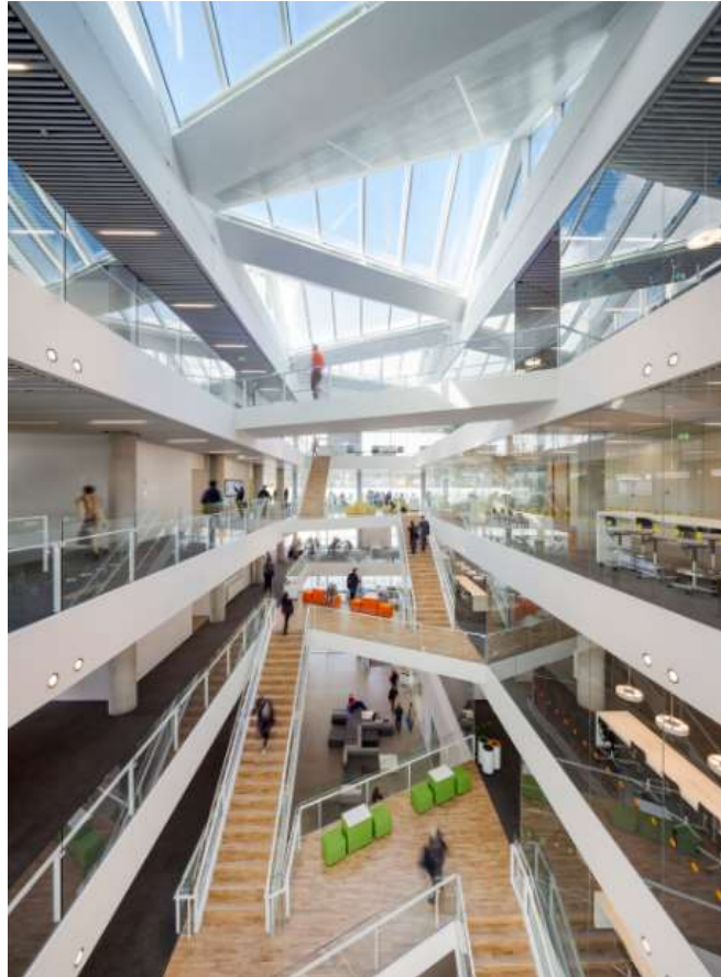
Figura N°5: Vista interna de circulación de caso 5
