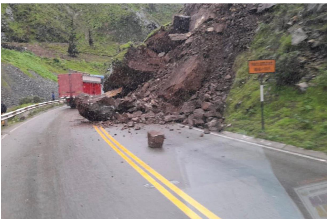
Figura 2. Km 86 de la Carretera Central - Perú
